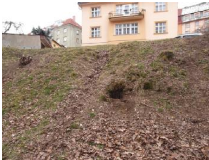
Stávající problematický erodovaný svah bez stabilizačního krytu
