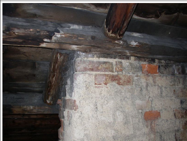
21. krov, přizděné dřevěné části
