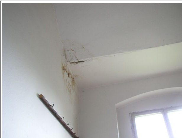
19. zatékání do střechy nad schody
