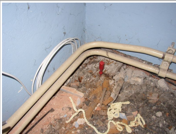
8. 2.NP poškozený stropní trám u zdi
