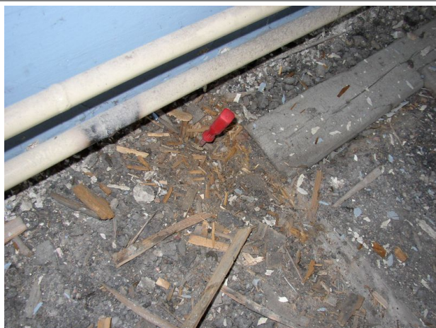
9. 2.NP poškozený stropní trám u zdi
