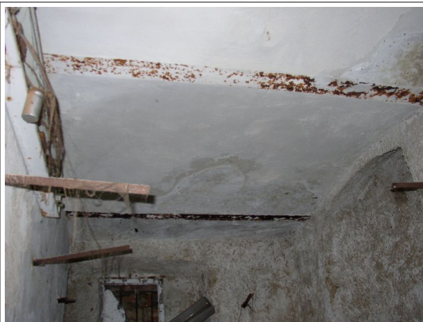
2. 1.PP koroze stropních nosníků
