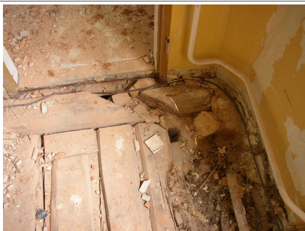
7. 2.NP obnažená stropní konstrukce, zeslabený trám
