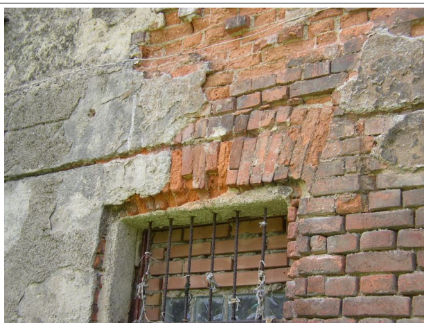
18. poškozené cihelné zdivo
