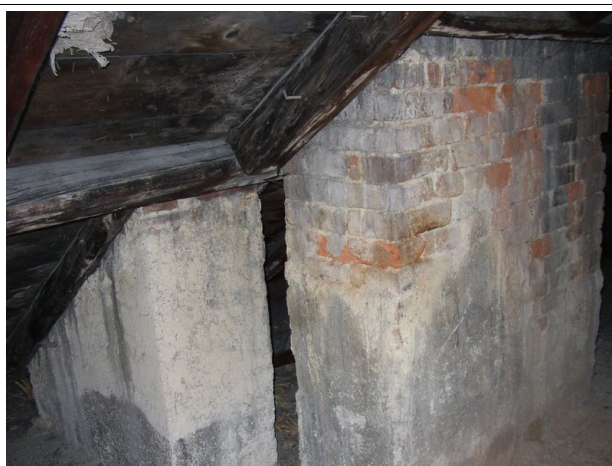
24. krov, přizděné dřevěné části
