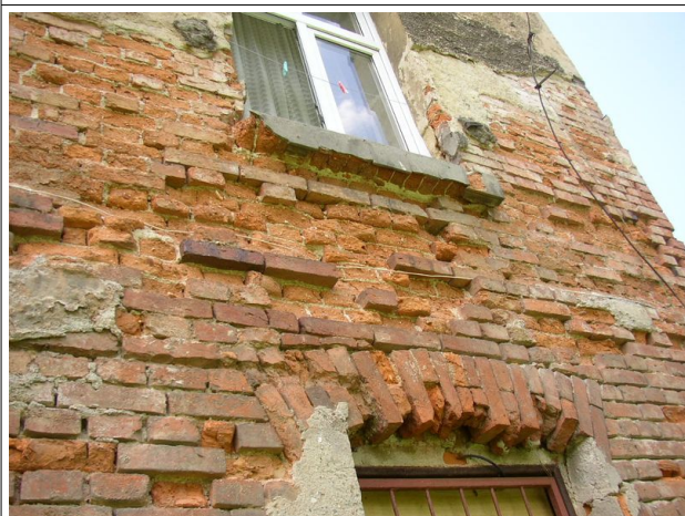
17. poškozené cihelné zdivo
