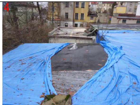
Foto č.6: Detail folie - Typický stav střešní krytiny
