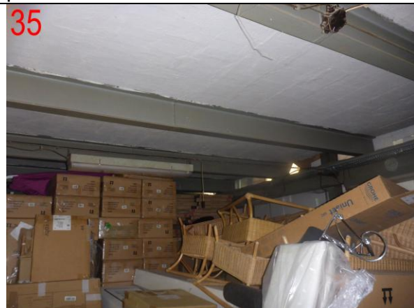
Foto č.35: Ocelová konstrukce stropu nad 1.N.P. vestavby do traktu DIII pavilonu D
