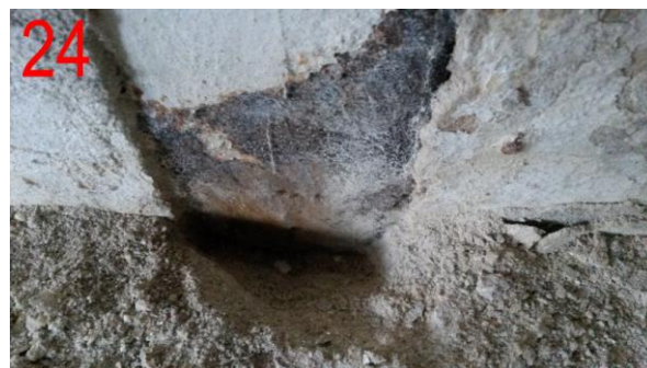
Foto č.24: Detail - pohled do sondy - povrchová koroze paty sloupku bez oslabení profilu
