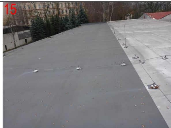
Foto č.15: Pohled na střechu pavilonu „E“
