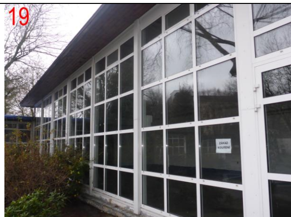
Foto č.21: Pohled na původní prosklenou stěnu lokálně porušenou prasklinami a zevnitř vyplněnou polystyrenovými deskami.
