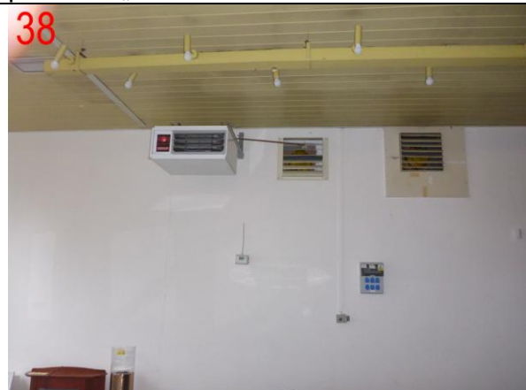
Foto č.38: Prvky rekonstruované vzduchotechniky a rozvodů elektřiny v pavilonu „E“
