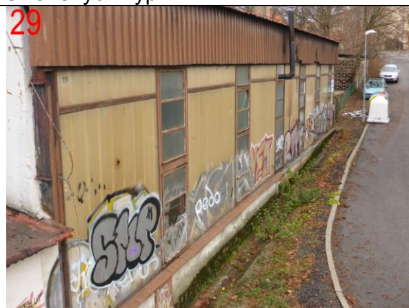
Foto č.29: Stav východní fasády do ulice Gorkého. Četné poruchy polykarbonátových desek-lamel a skleněných výplní
