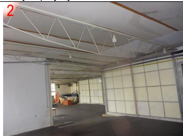
Foto č.4: Detail provedení provizorního zakrytí poškozeného střešního pláště
