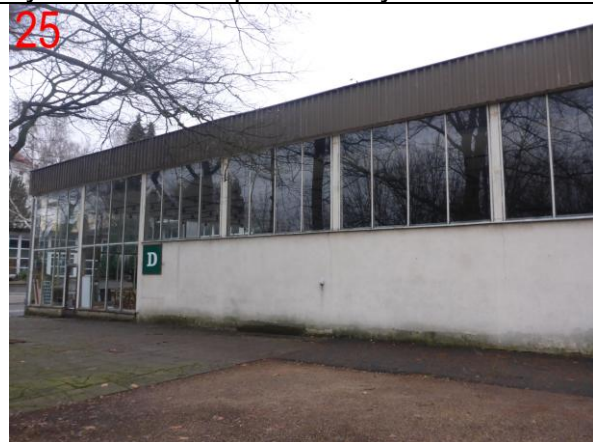
Foto č.27: Pohled na východní stěnu z plastových lamel
