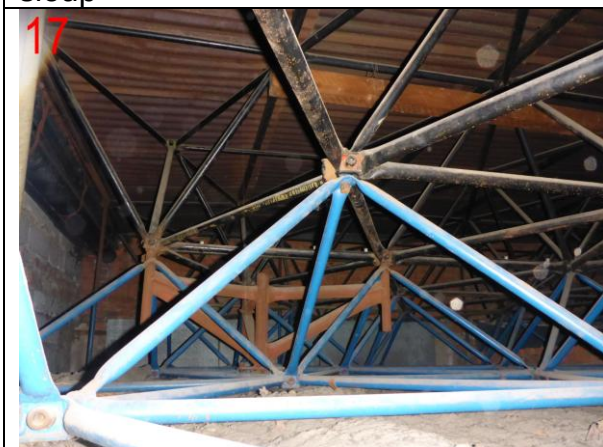
Foto č.17: Pohled na prostorovou příhradovou konstrukci střech pavilonu „E“ Vykonzolovaná hlavice uložení na sloup
