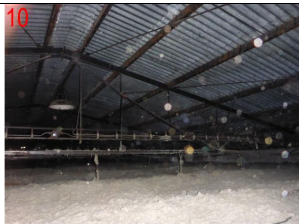
Foto č.12: Střešní konstrukce v traktu DIII - vložený podélný masivní ocelový vazník ve vrcholu .
