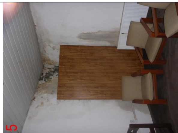
Foto č.5: Výrazné zatékání v rohu přístavby v severní části.
