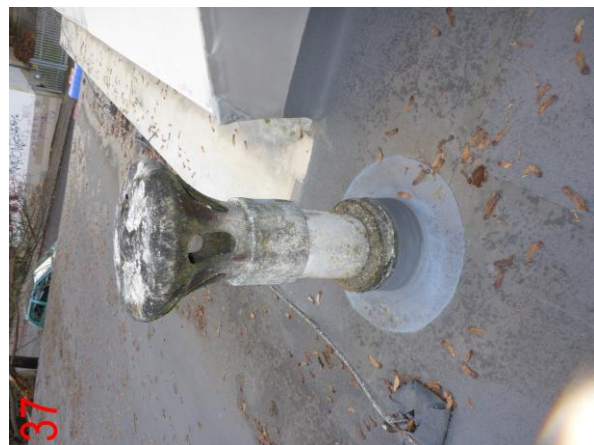
Foto č.37: Prvky hlavice odvětrání obsahující azbestová vlákna
