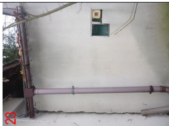
Foto č.23: Výrazné odtržení přístavku od vedlejšího přístavku. Havarijní stav
