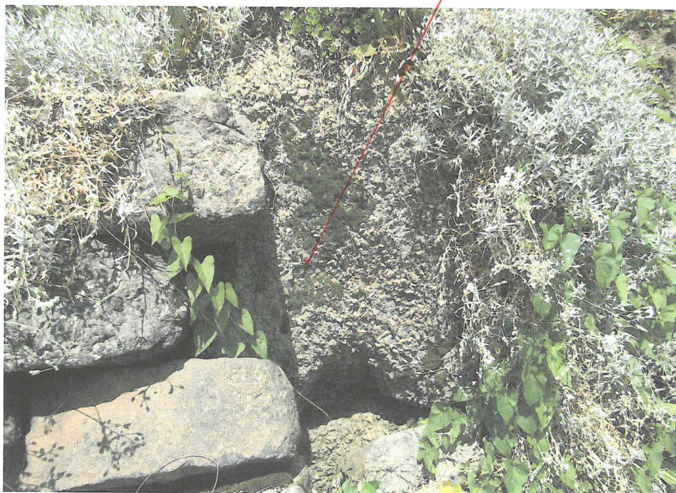
k.ú. Kateřinky u Liberce p.p.č.36, 38 v prostoru opěrné zdi skalní podloží vyklíňuje na povrch terénu- blokovité zvětrávání žuly
