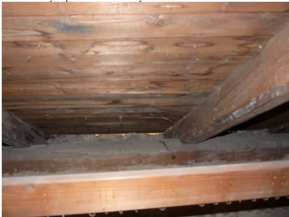
Drobné štěrby do podstřeší hlavní budovy
