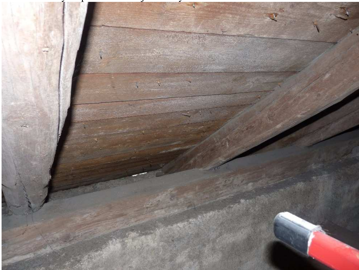
Drobné štěrbiny do podstřeší vedlejší budovy
