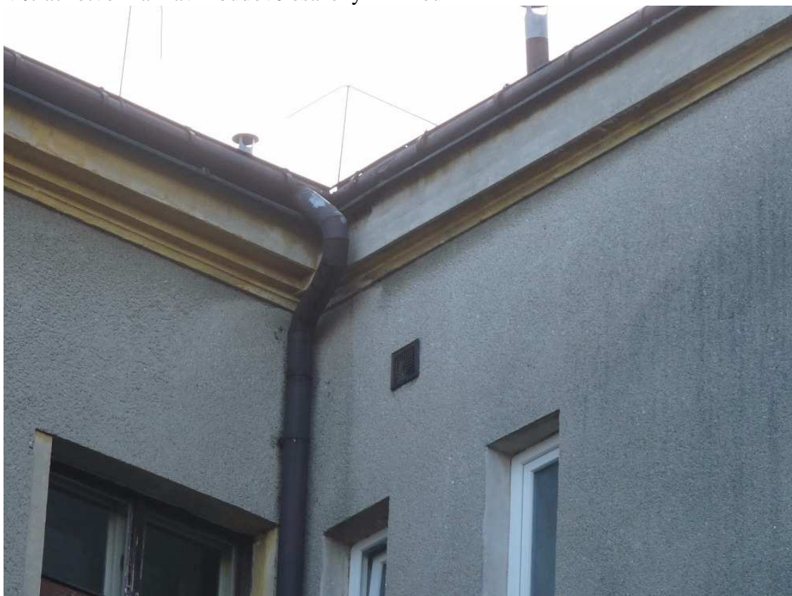
Větrací otvor na hlavní budově osazený mřížkou
