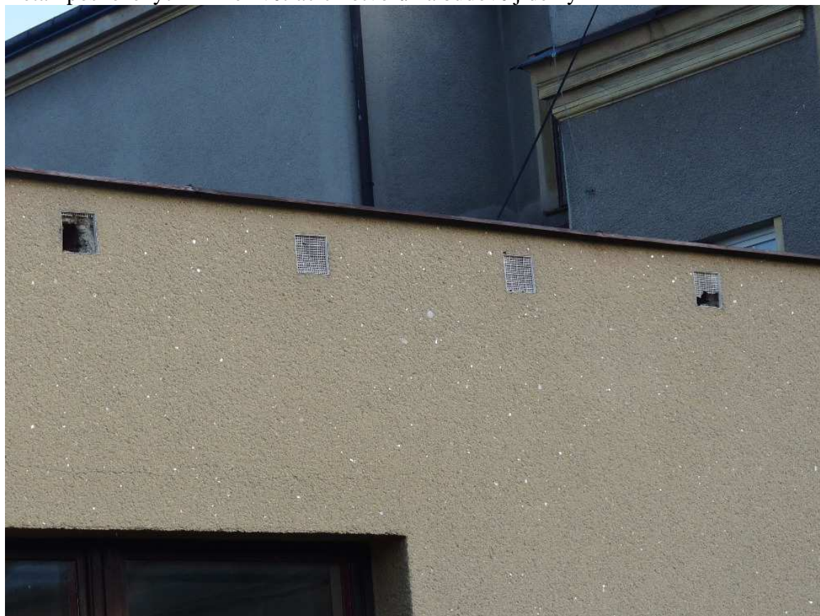
Detail poškozených mřížek větracích otvorů na budově jídelny
