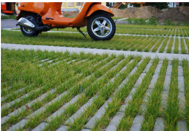
drenážní, zatravňovací dlažba - betonová, lineární
