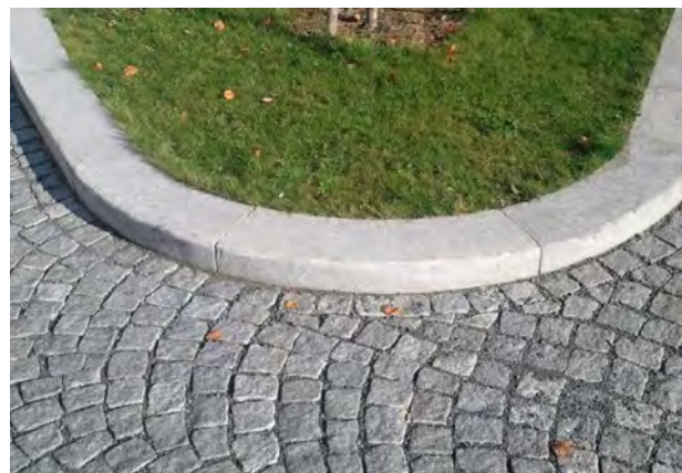
kamenná výdlažba přejezdových ploch kamenná obruba
