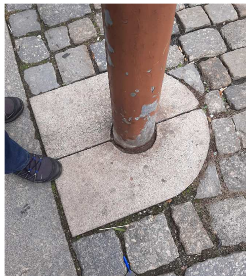
Detail stávající úpravy paty stožáru (bude zachováno)
