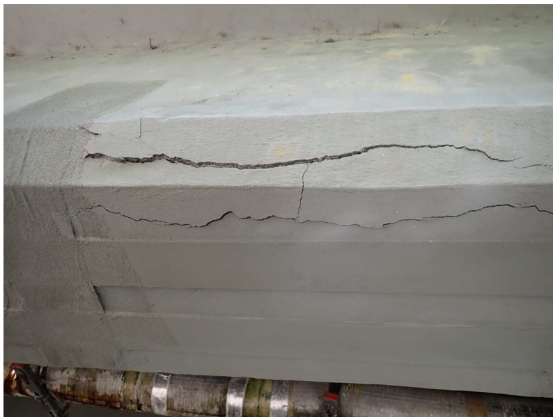
Trhliny ve výtakovém trámu od středu vpravo – od nabobtnané výztuže odtržení krycí vrstvy betonu
