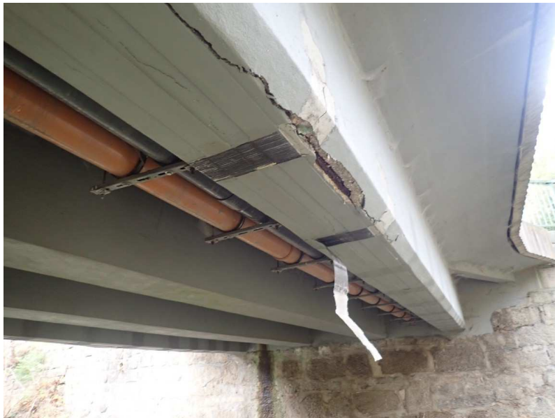
Odpadlá krycí vrstva betonu, včetně odtržení kotvící tkaniny + trhliny v podhledu vtokového trámu v délce cca 2.0m
