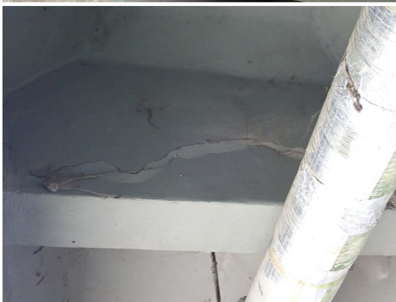
Trhlina ve středním výtakovém příčnicku
