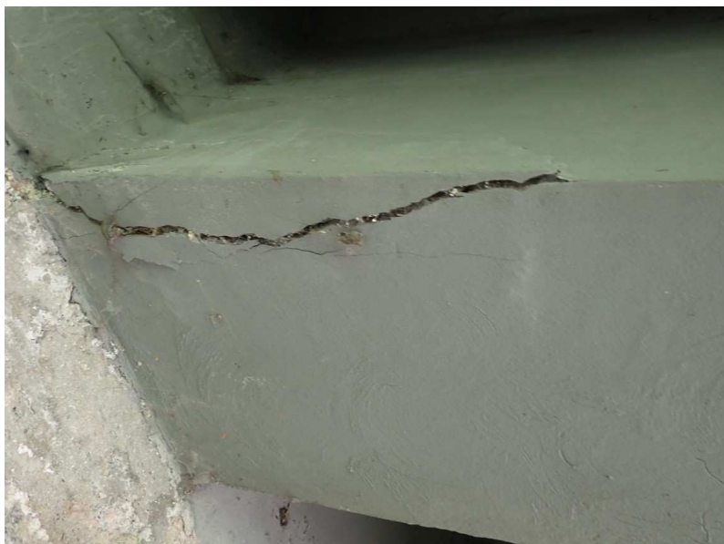
Trhlina v místě uložení u 2. trámu od výtoku vlevo o šířce 8 mm – oproti předchozí HPM nedošlo ke zhoršení
