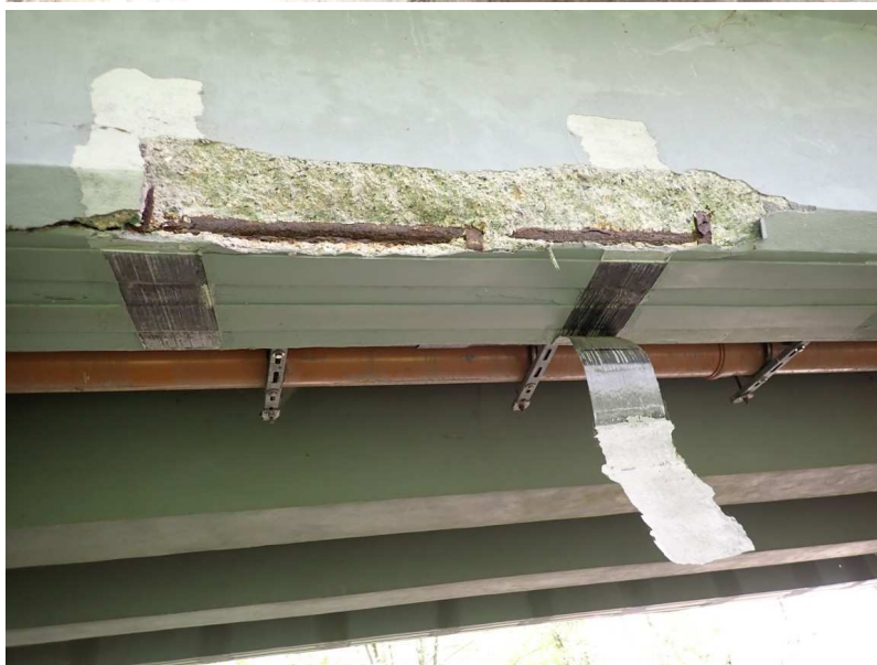
Detail poškození vtokového trámu
