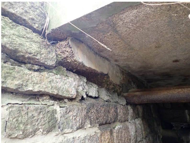
Poškozená pravobřežní opěra, resp. úložný práh na vtoku – silná degradace betonu
