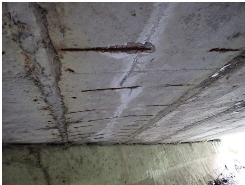
Podhled NK s lokálně obnaženou korodující výztuží
