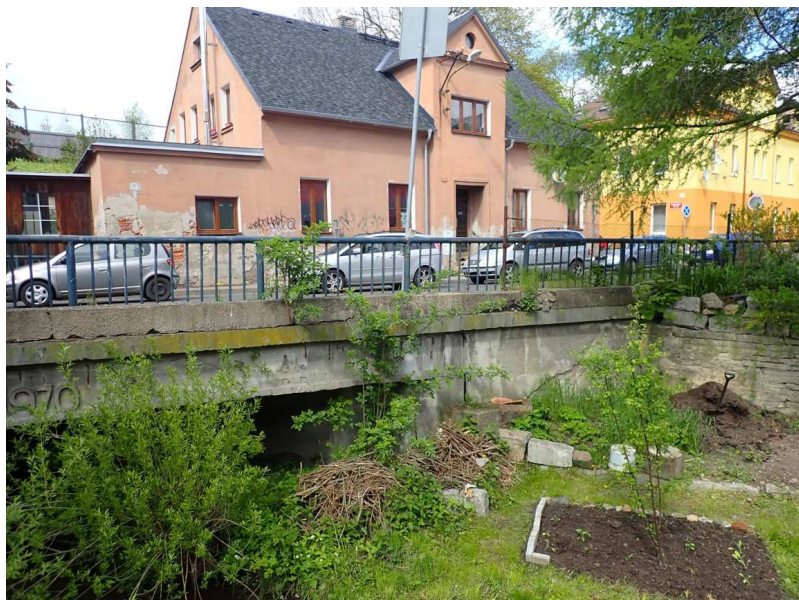
Pohled na vtokovou římsu a vtokové křídlo vpravo
