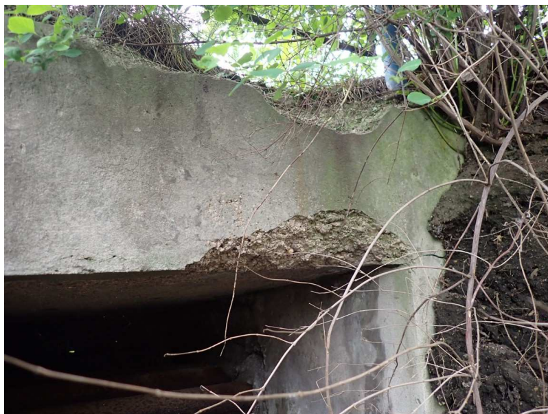
Degradace betonu boku NK, resp. římsy, na výtoku
