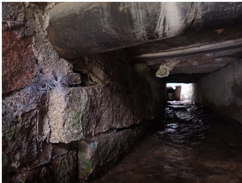
Podhled NK od výtoku a pohled na pravobřežní opěru – lehce vyboulená a bez spárování
