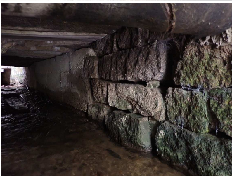
Poškozená levobřežní opěra na výtoku
