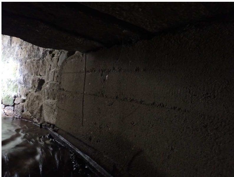
Dozděná a opravená levá opěra na vtoku
