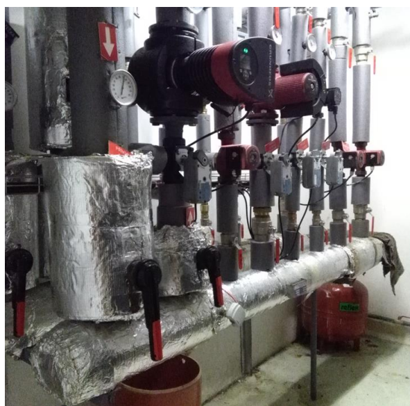
Obr. č. 6 – Rozdělovač a sběrač ÚT
