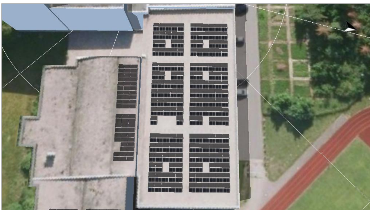
Obrázek: 1. Umístění modulu - Střecha 1-Oblast modulu Východ
