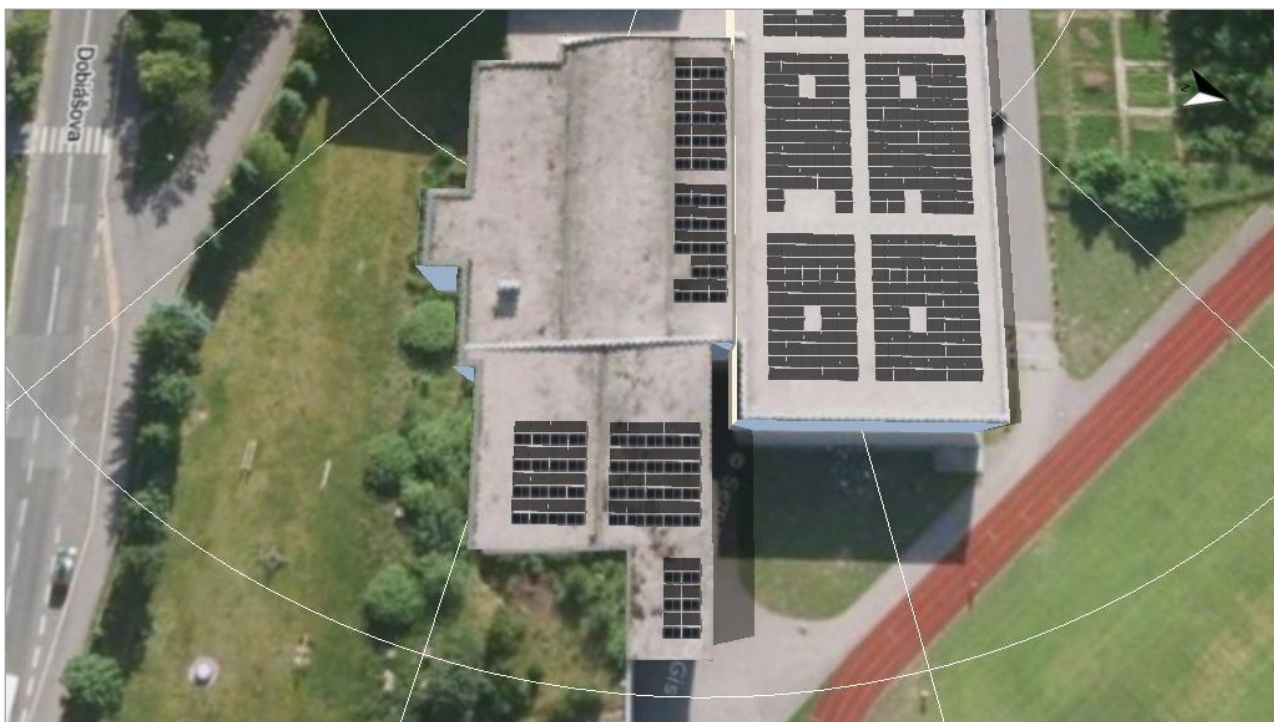
Obrázek: 2. Umístění modulu - Střecha 2+3-Oblast modulu Východ
