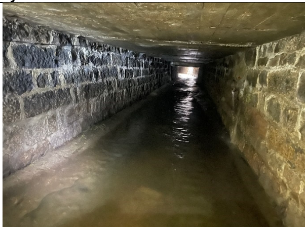
Celkový pohled na předmětný úsek údržby – výrazné poškození dna, nutné přespárování zdiva
