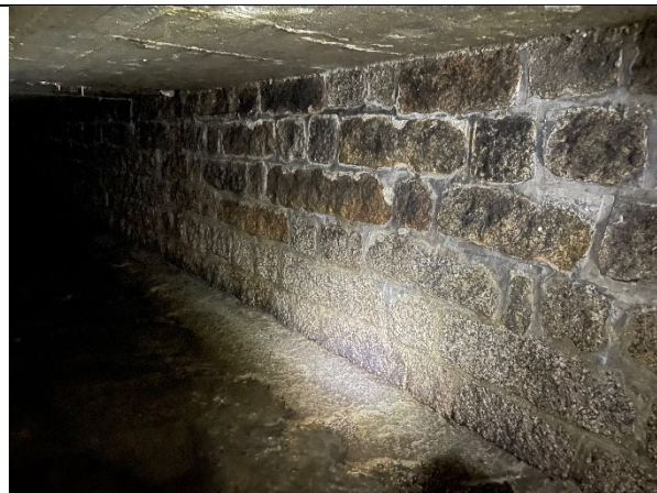
Pohled na úsek mimo čp.270 – stávající strop bude zachován, poškozené dno, nátrže
