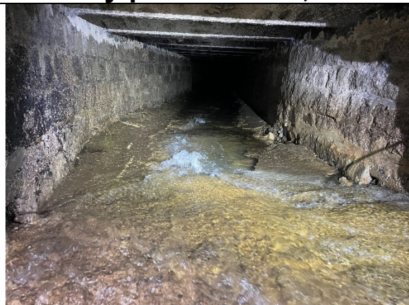
Pohled od místa napojení na stávající dnový práh ř.km 0,399 – poškozené dno, nátrže
