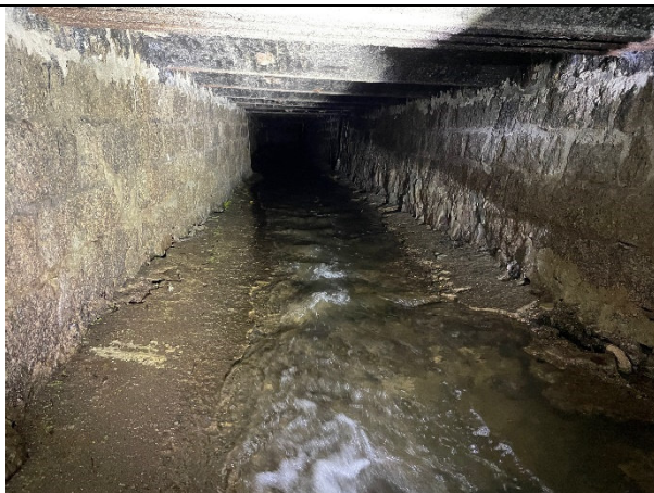
Pohled na stávající stav dna a klenbového stropu pod čp.270, který bude kompletně vybourán
