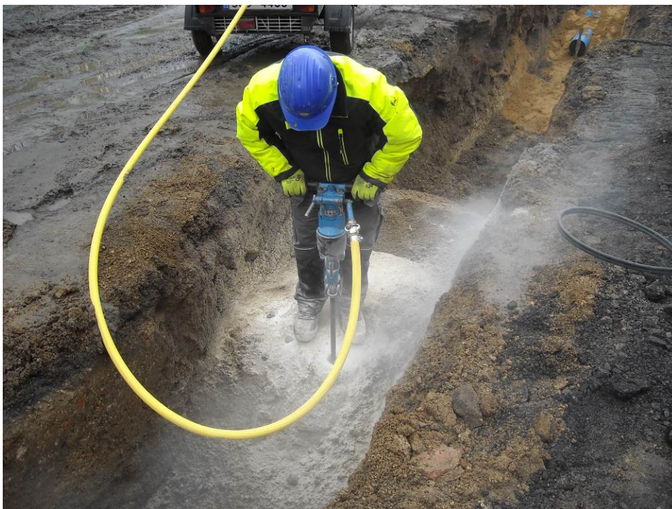
SO 316, rýha cca km 0,120; ruční navrtávání horniny (foto zhotovitel, dne 27.2.2025)
