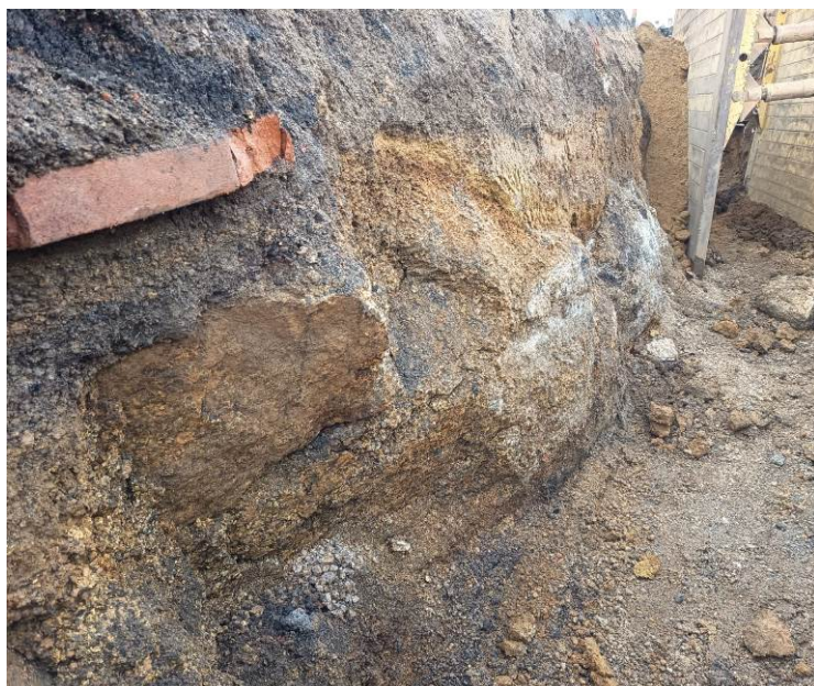
SO 316, rýha cca km 0,113-0,135, pohled na stěny rýhy v místech vybouraných skalních výchozů (foto dne 4.3.2025)
