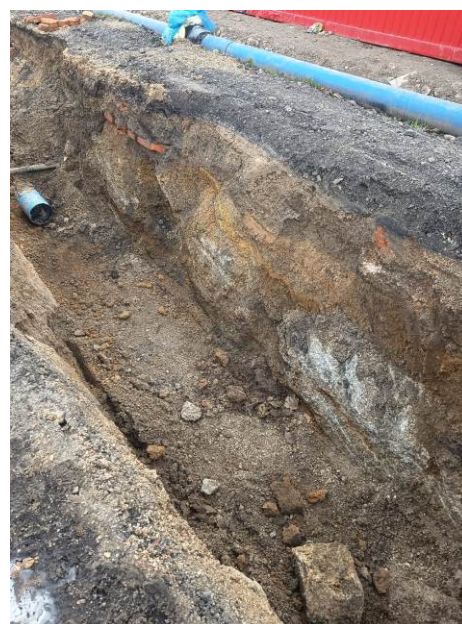
SO 316, rýha cca km 0,113-0,135, pohled na stěny rýhy v místech vybouraných skalních výchozů (foto dne 4.3.2025)
