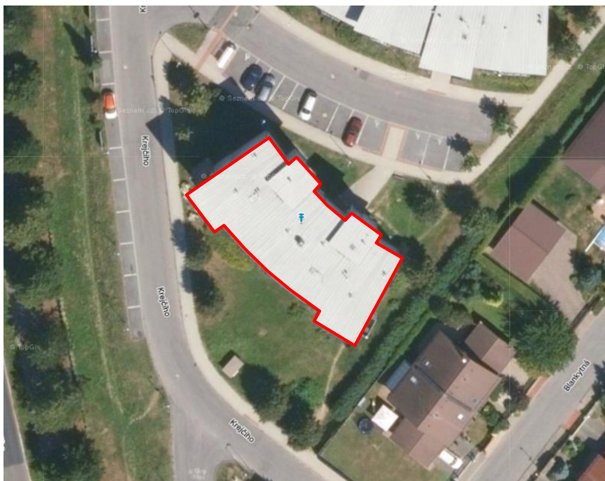
Obr. 25: Vyznačení plochy k instalaci FVE na střeše objektu - BD Krejčího 1178/15. Zdroj: https://mapy.cz .
