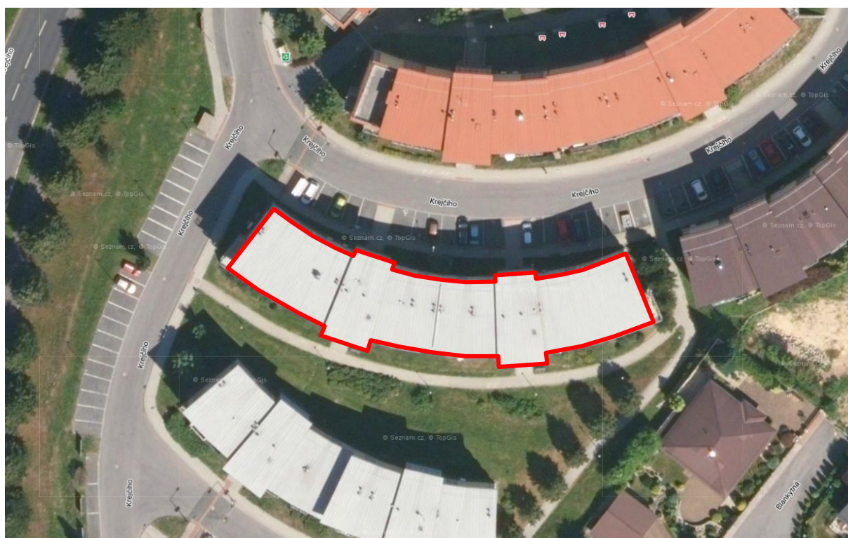
Obr. 22: Vyznačení plochy k instalaci FVE na střeše objektu – BD Krejčího 1175/9. Zdroj: https://mapy.cz .
