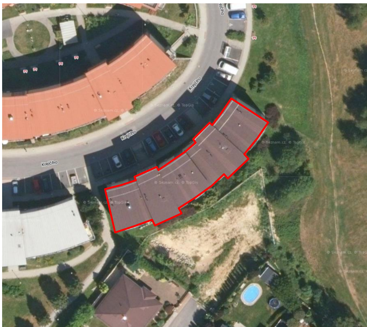
Obr. 23: Vyznačení plochy k instalaci FVE na střeše objektu – BD Krejčího 1176/11. Zdroj: https://mapy.cz .
