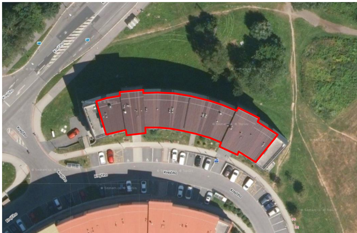
Obr. 19: Vyznačení plochy k instalaci FVE na střeše objektu - BD Krejčího 1172/3. Zdroj: https://mapy.cz .
