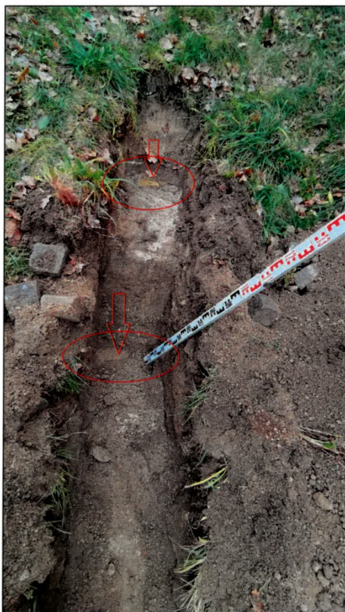
Obr.č.7.1.1: Ochranná páska nad průběhem plynovodu v sondě S8
