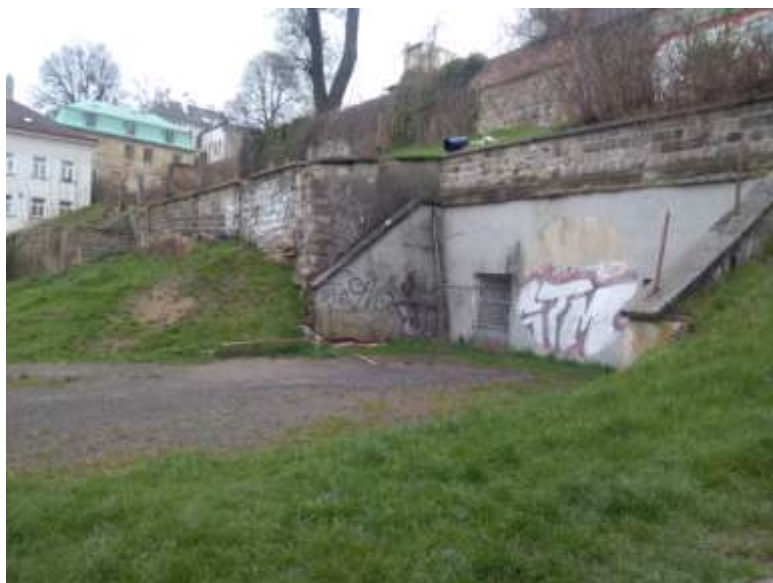
Obr. 1: Opěrné zídky a vchod do protiletectvého krytu.
