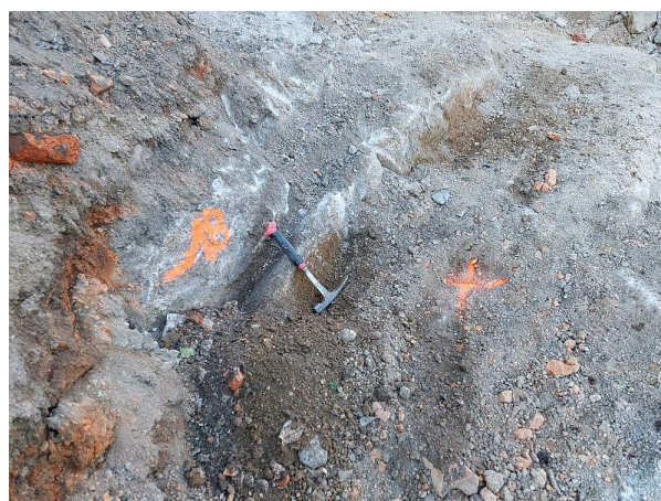
SO 101 a SO 110, výkop cca km 0,120, horniny v úrovni projektované konstrukce vozovky a zemní pláň (foto 13.5.2025)
