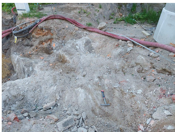
SO 101 a SO 110, výkop cca km 0,120, horniny v úrovni projektované konstrukce vozovky a zemní pláň (foto 13.5.2025)
