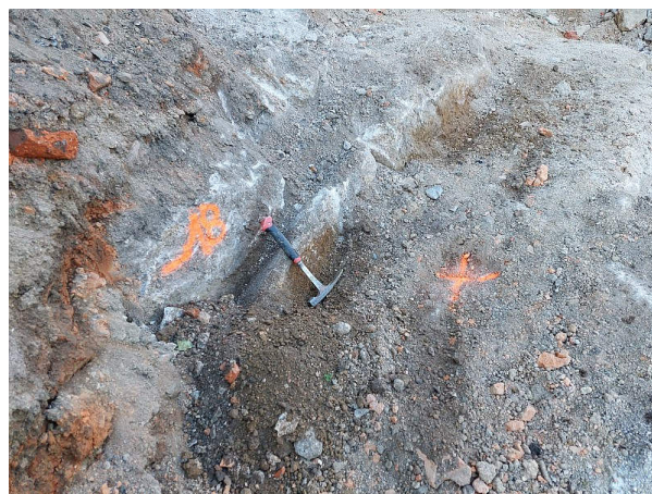
SO 101 a SO 110, výkop cca km 0,120, horniny v úrovni projektované konstrukce vozovky a zemní plně (foto 13.5.2025)
