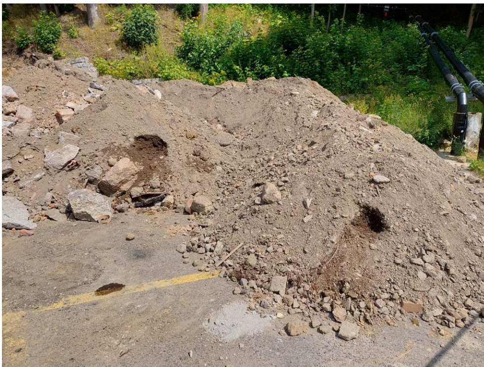
ulice Pastýřská, deponie vytěžené zeminy SO 313, celkový pohled
