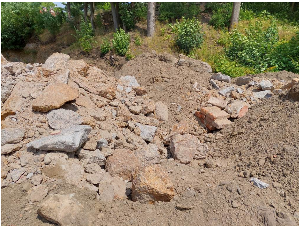
ulice Pastýřská, deponie vytěžené zeminy SO 313 fragменты stavebních hmot a úlomky hornin
