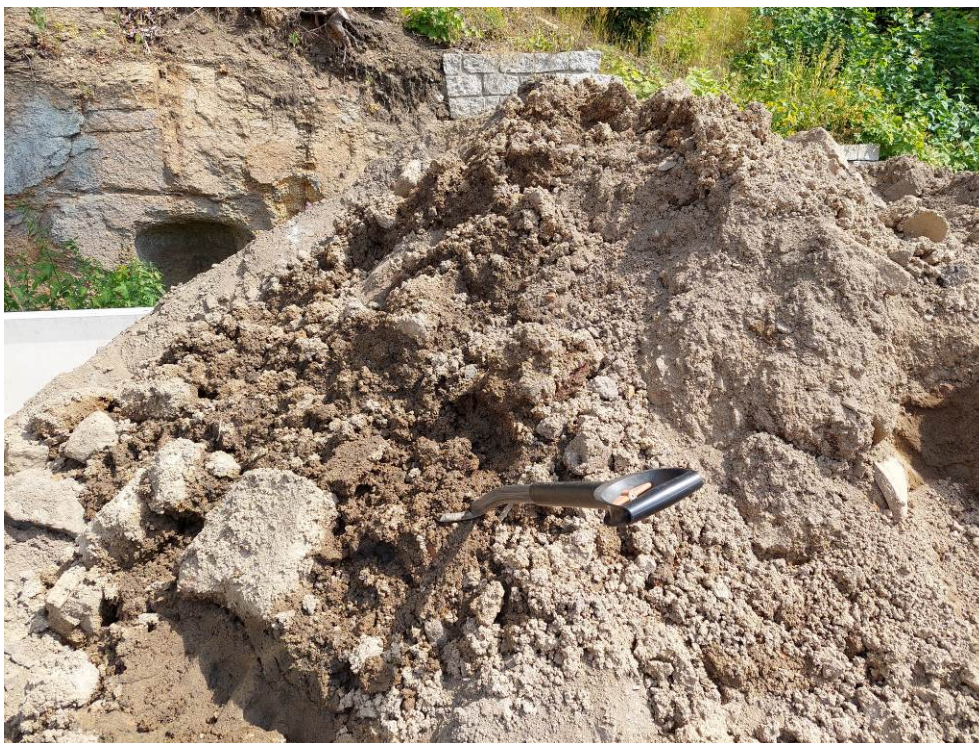
ulice Pastýřská, deponie vytěžené zeminy SO 313
