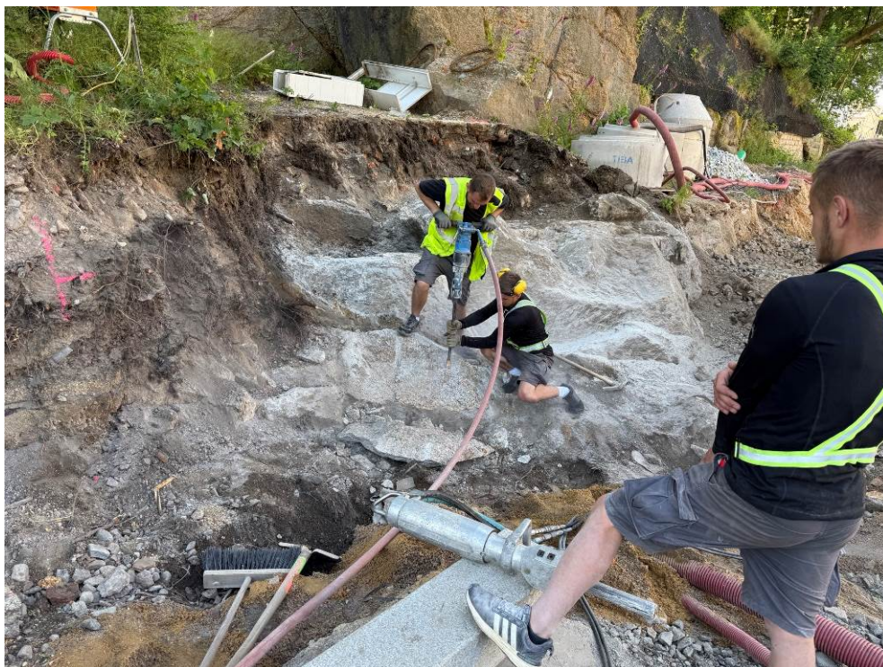
ruční navrtávání otvorů v pravidelném rastru, následné dolamování horniny hydraulickým klínem (foto 30.6.2025)
