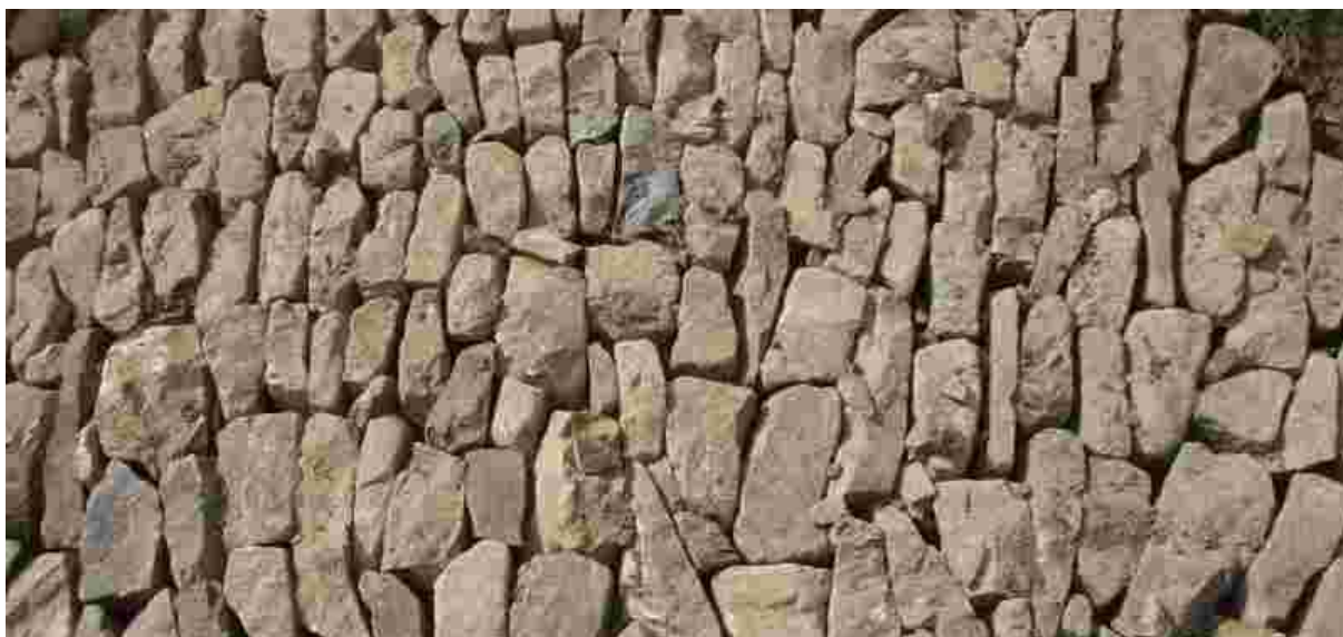
kámen ložený na výšku – štět (ještě nezasypaný).
