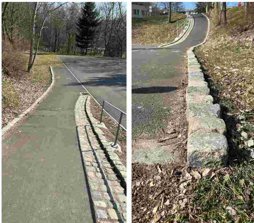
Obr. 24 Pohled shora, obr.25 Pohled ze spodní části – úrovně hřiště
