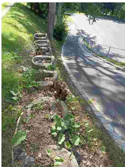
Obr.7: Betonová zárubní zeď: zaplevelená – stav po likvidaci horní části náletů dřevin.
