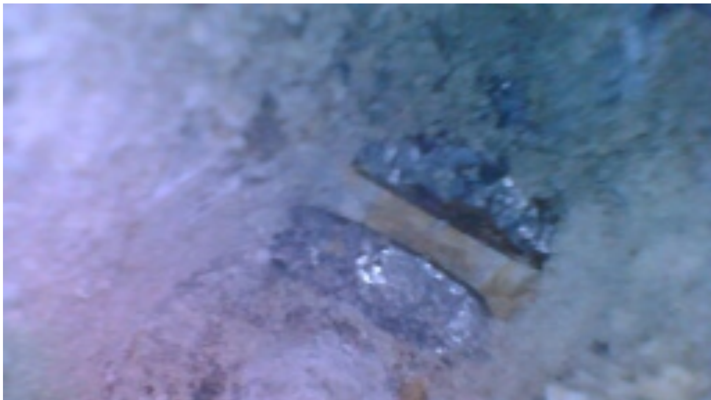
31 Nosná konstrukce - sondy k předpínací výztuži
