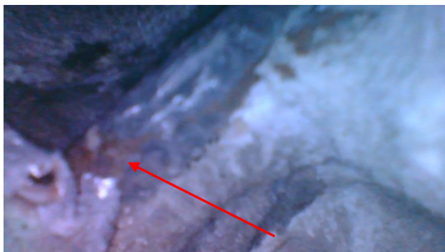
Obr. 1 a 2 – Sondy do kabelových kanálků – povrchová koroze
