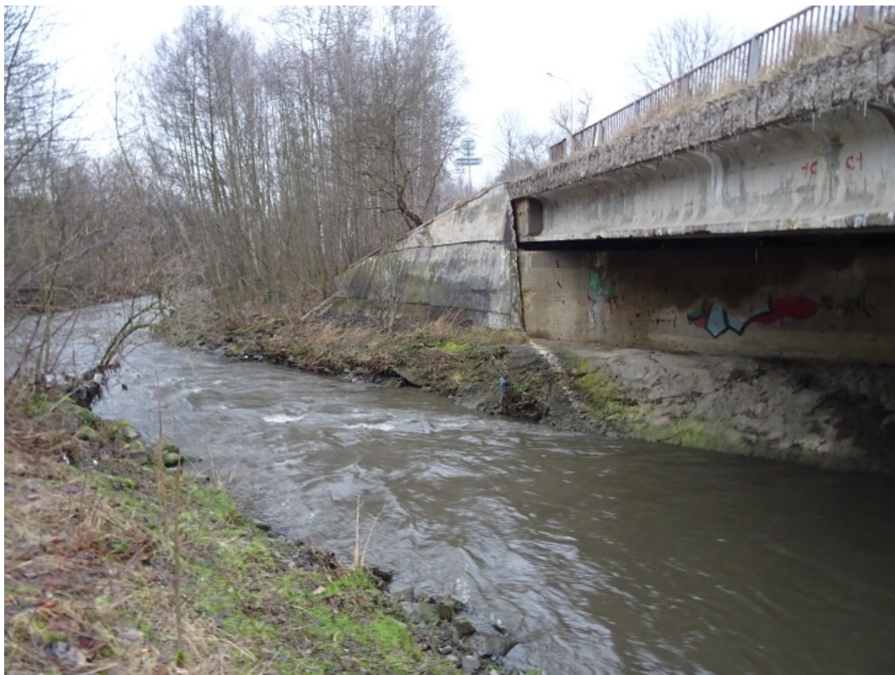
55 Konstrukce křídél
