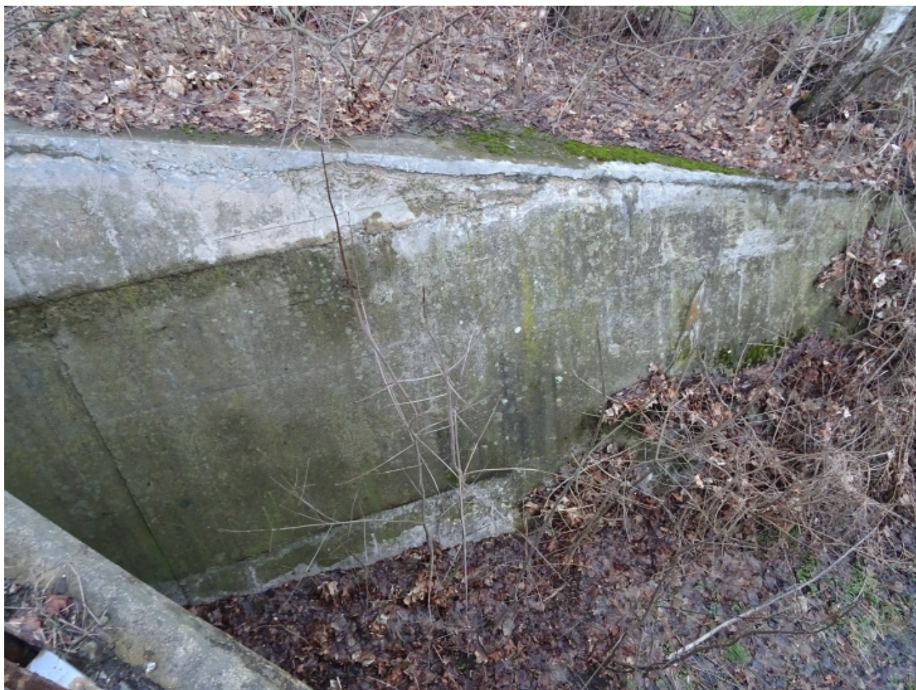
56 Konstrukce křídél
