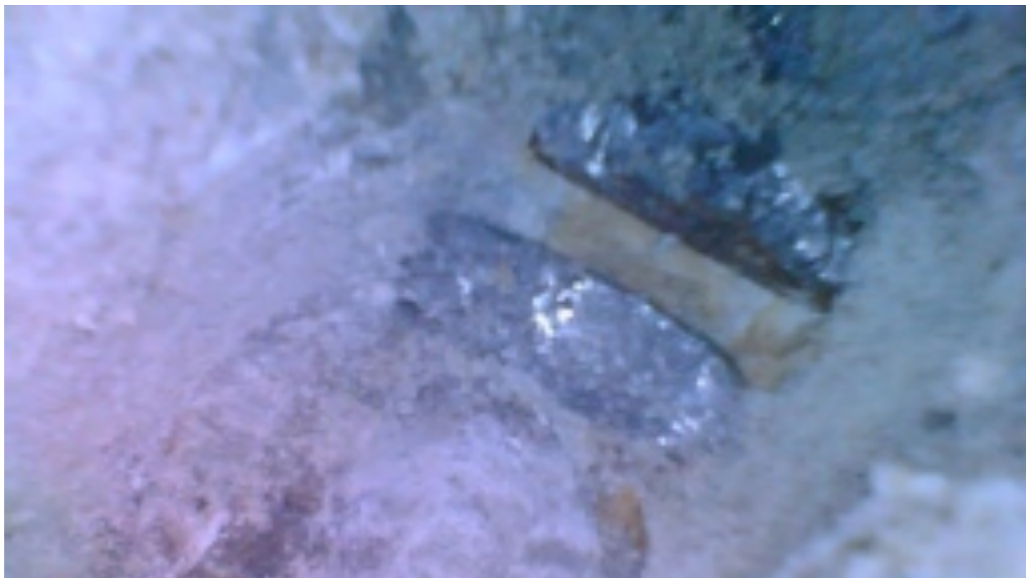
30 Nosná konstrukce - sondy k předpínací výztuži
