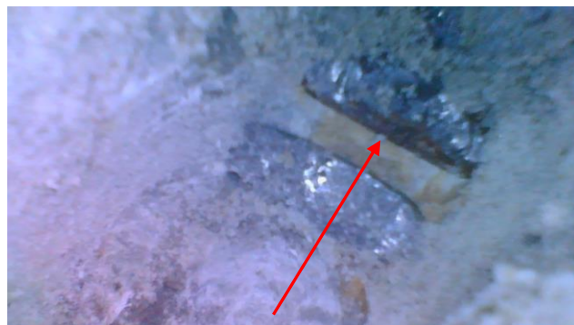
Obr. 1 a 2 – Sondy do kabelových kanálků – povrchová koroze
