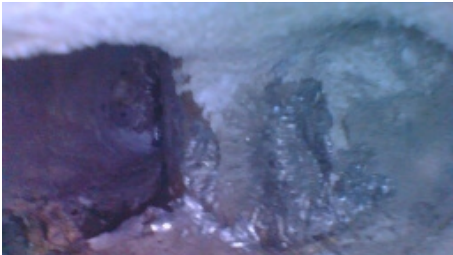
34 Nosná konstrukce - sondy k předpínací výztuži
