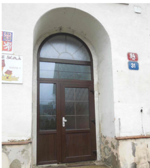
Hlavní vchod – plastové dveře s izol.dvojsklem
