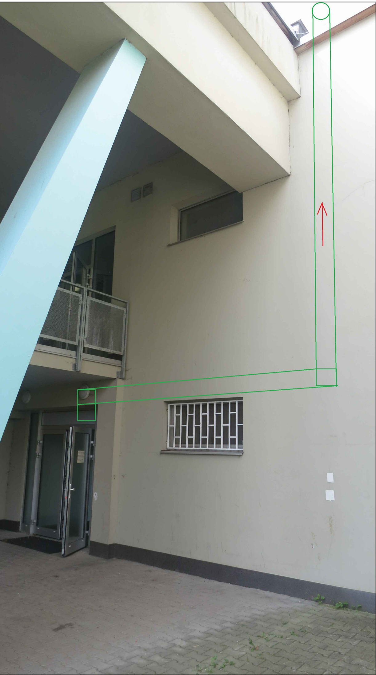
SCHÉMATICKÉ NAZNAČENÍ VEDENÍ POTRUBÍ PO FASÁDĚ ODTAHOVÉHO POTRUBÍ
