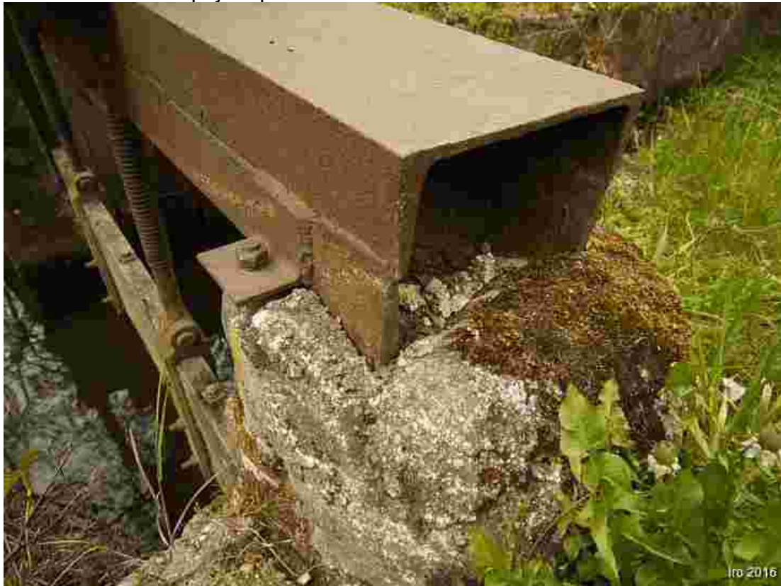
Stavidlo 1: Detail spojení pouchu a betonového základu
