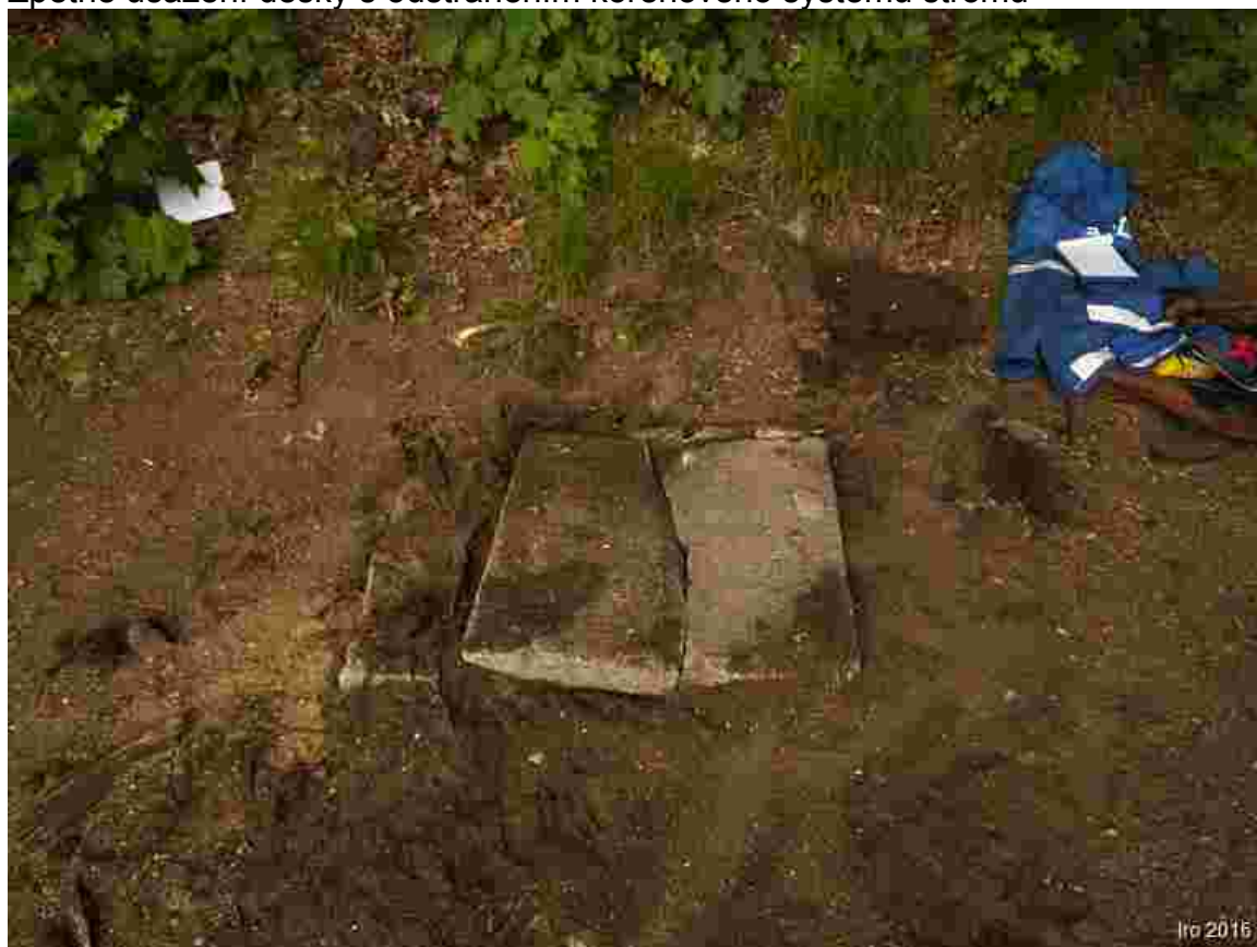
Zpětné usazení desky s odstraněním kořenového systému stromu
