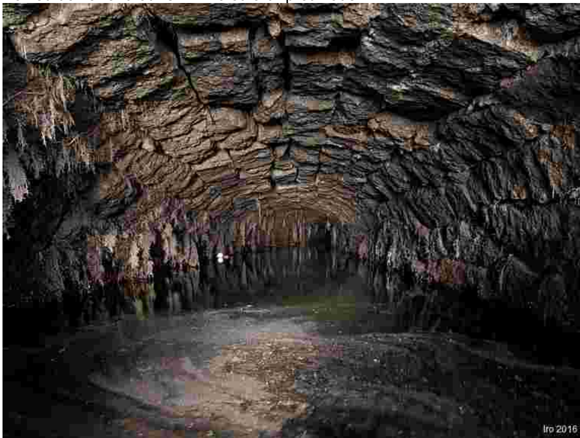
Pohled do náhonu od revizního otvoru "proti vodě"
