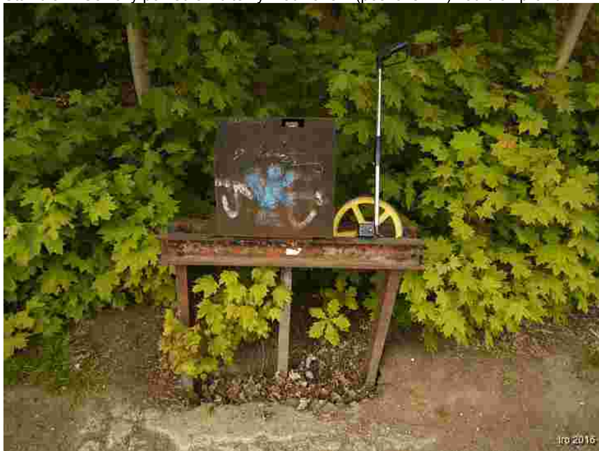
Stavidlo 4: Celkový pohled s viditelným odklonem (poškozením) vodících profilů
