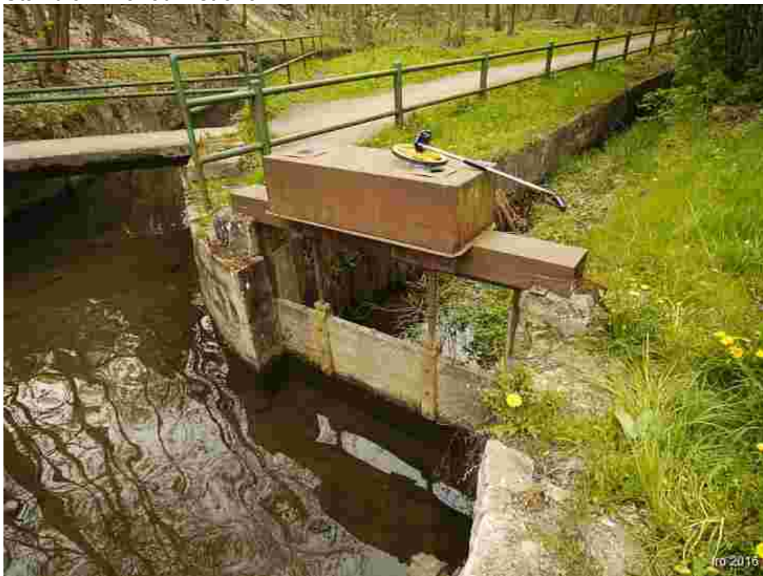
Stavidlo 1: návodní strana
