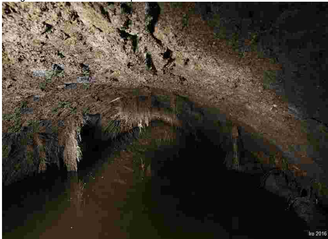
Fotografie vnitřní části náhonu "proti vodě"
