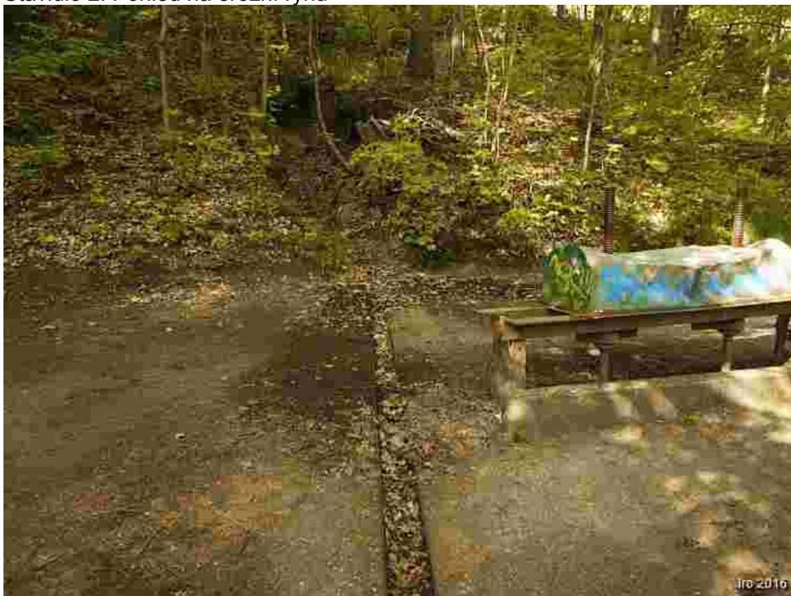
Stavidlo 2: Pohled na erozní rýhu
