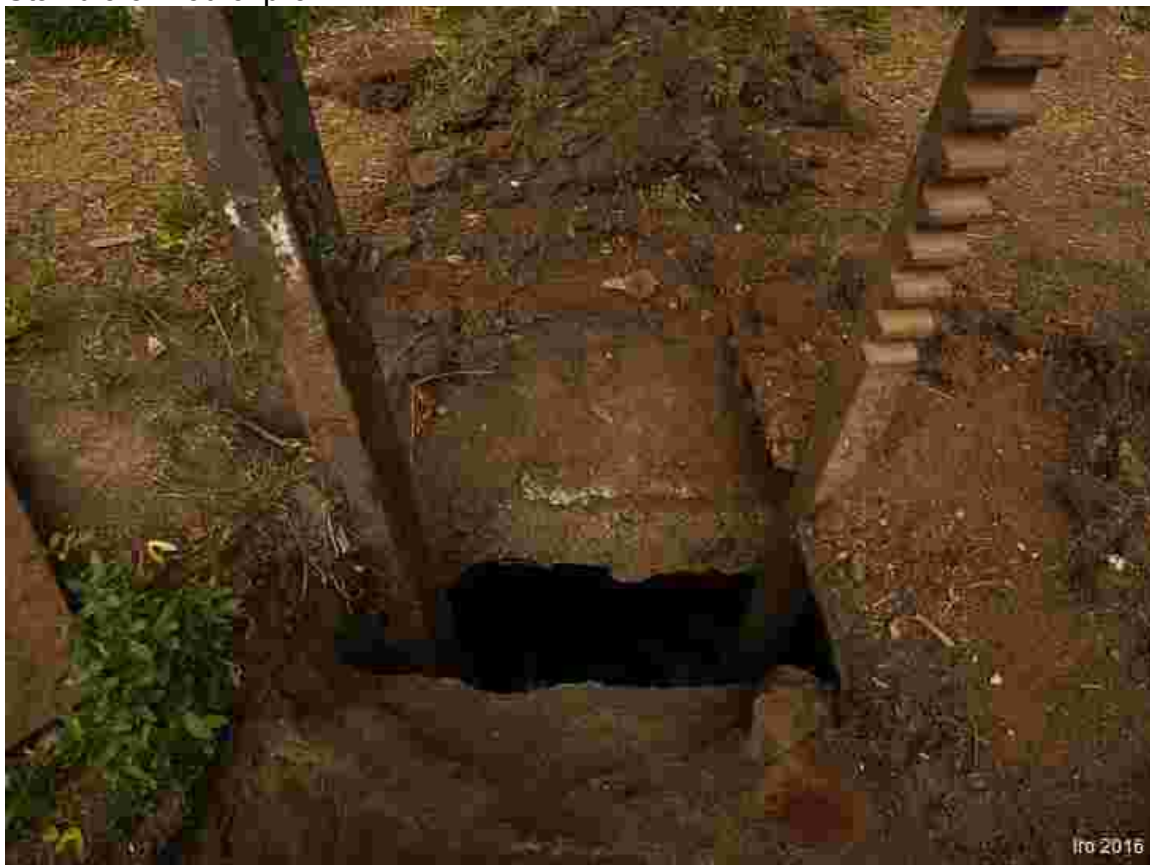
Stavidlo 3: Vodící profil
