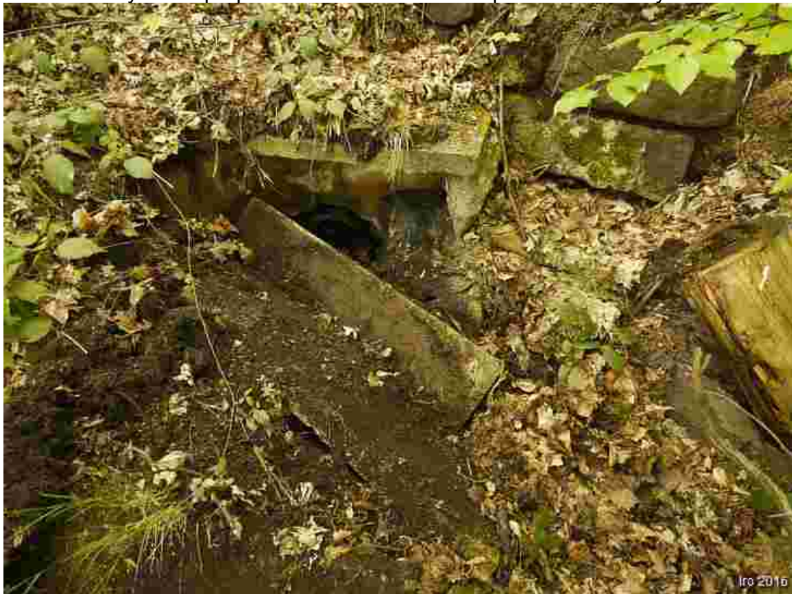
Stavidlo 2: Vyústění propustku občasné vodoteče pod ulicí Svobody
