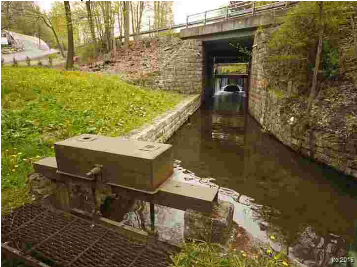
Stavidlo 1: Celkový pohled
