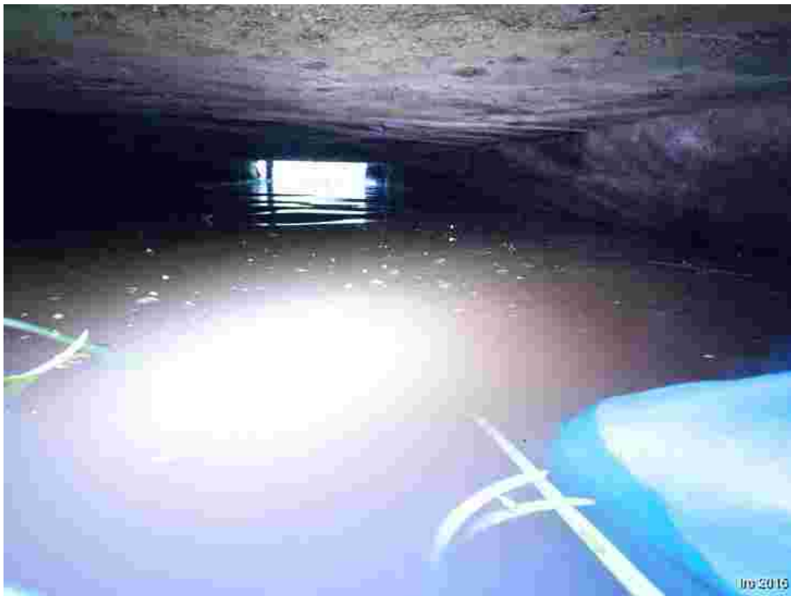
Stav opěru nosníku - napojení na náhon
