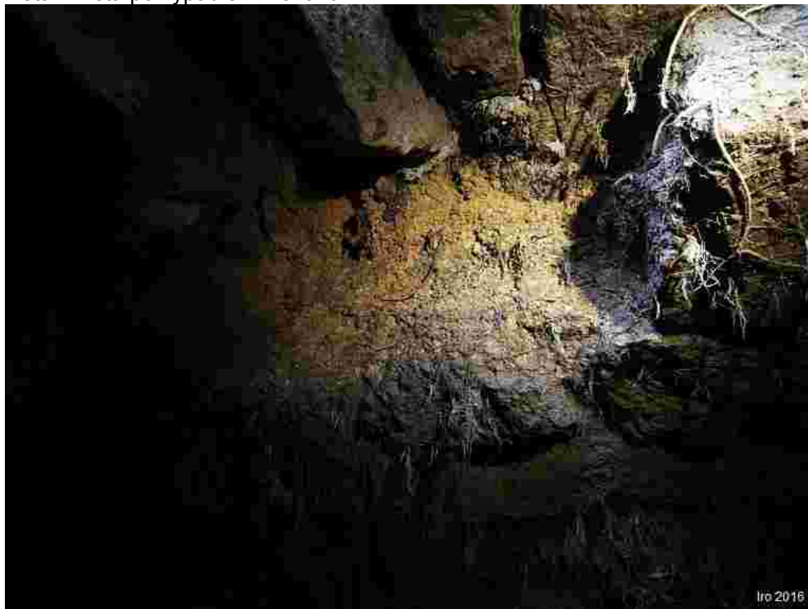
Detail místa po vypadlém klenáku
