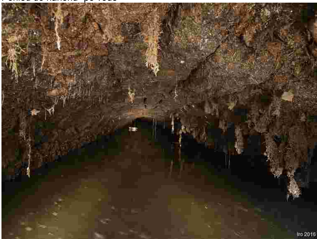
Fotografie opěráků (nahore a dole na fot.) a skladba klenby
