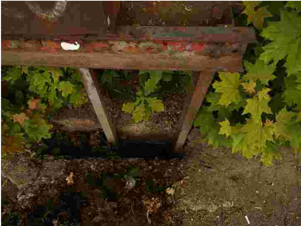
Stavidlo 4: Vodící profil
