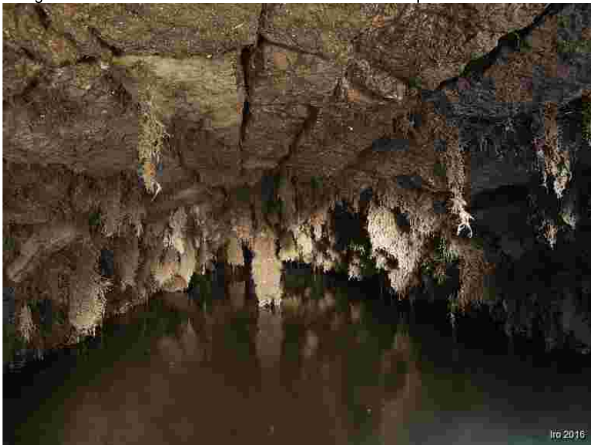
Fotografie vnitřní části náhonu v místě revizního otvoru 2 "proti vodě"
