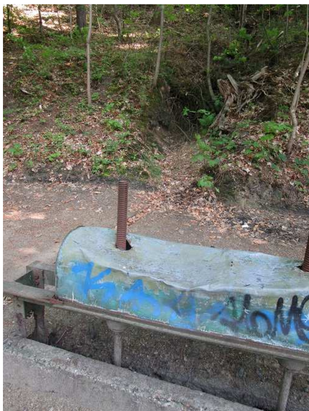
Stavidlo č. 2 (vymístění mimo cestu)
