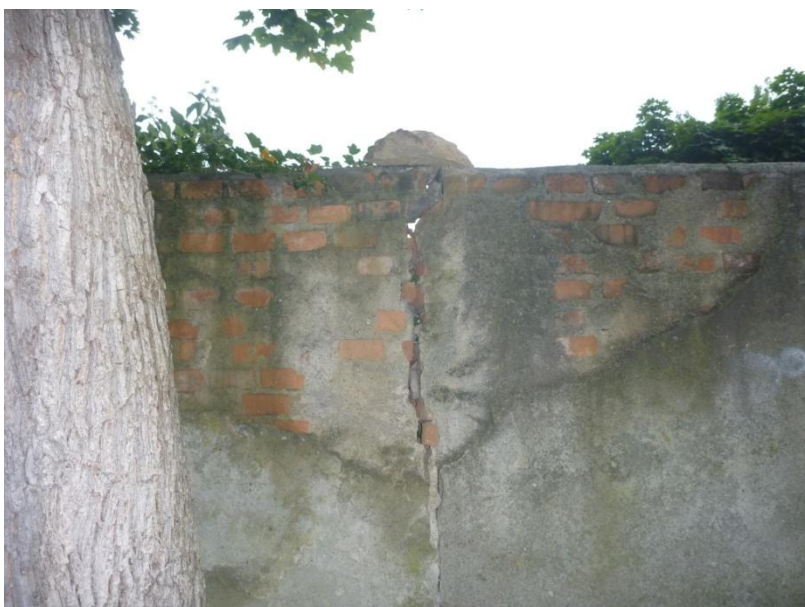
Svislá trhlina na zdi B pohled z pozemku p.č. 923/1
