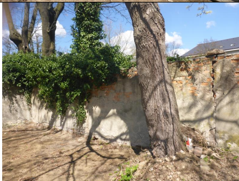
Pohled na zeď v části „B“ z prostoru pozemku 923/1 od ulice Komenského Silná svislá trhlina ve zdivu v místě původního betonového sloupku
