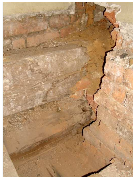
Obr.č.56 : totální destrukce zhlaví a uložení ST /vodorovná kce 4.NP/ Odběr vzorku VZ6
