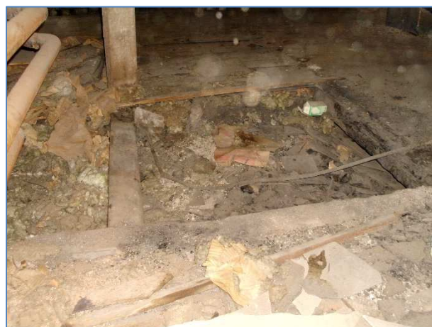
Obr.č.33 : detail požárem poškozené vodorovné kce posledního NP
