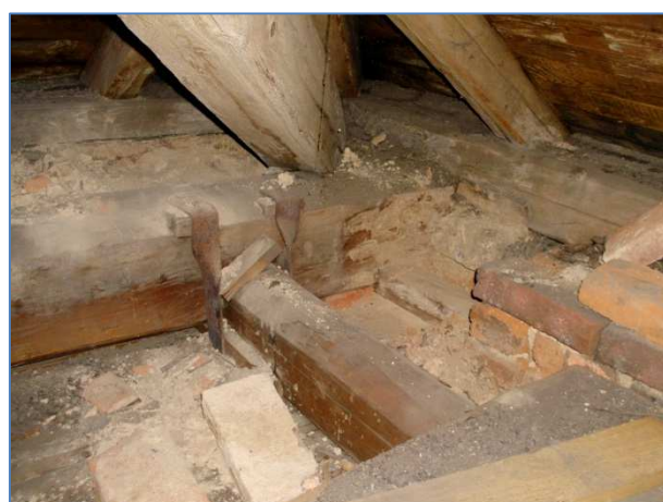
Obr.č.2: detail nároží - sonda S1
