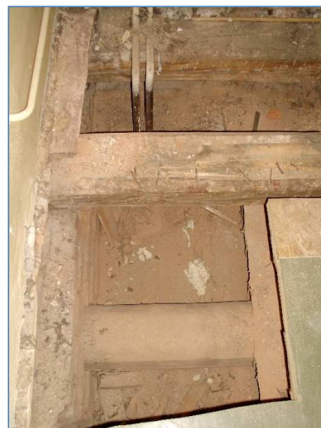
Obr.č.75 : detail uložení ST a RT na vnitřní nosné zdi
