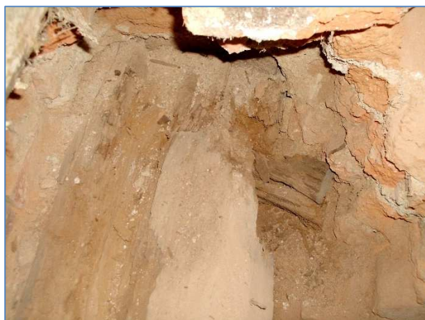
Obr.č.74 : detail totální destrukce dřevní hmoty
