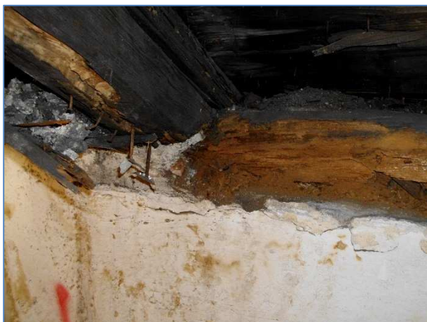
Obr.č.43 : totální destrukce konců krokví ve spoji s pozednicí
