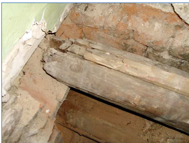
Obr.č.87 : totální destrukce zhlaví RT
