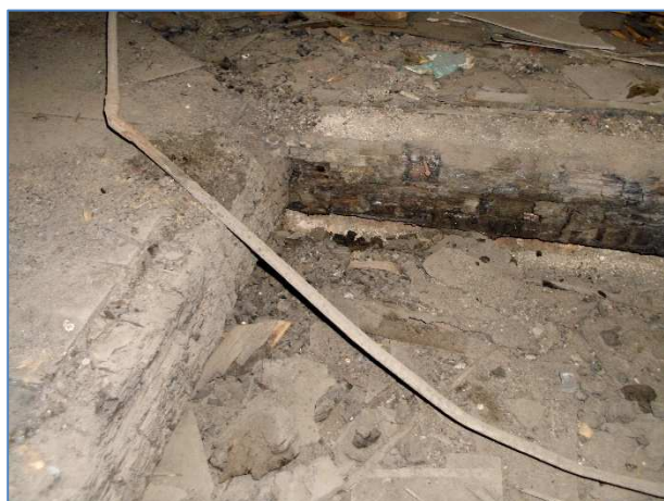
Obr.č.32 : detail požárem poškozené vodorovné kce posledního NP
