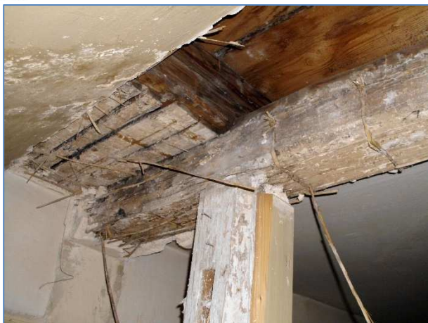
Obr.č.63 : detail spoje stojiny s průvlakem
