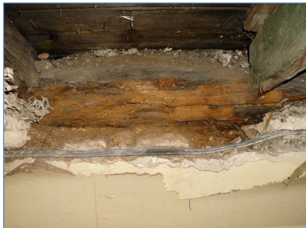
Obr.č.68 : totální destrukce pozednice Odběr vzorku VZ7
