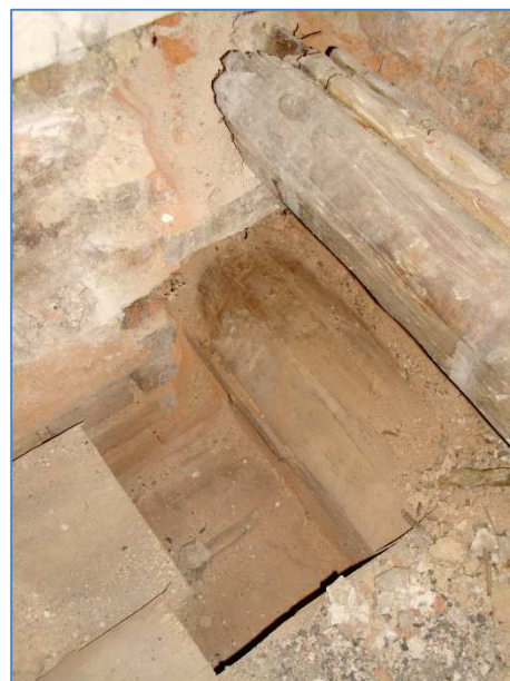
Obr.č.88 : havarijný stav ST v oblasti kotvení /uložení + zhlaví/
