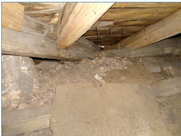
Obr.č.25: detail destrukce dř. kcí úžlabí v sondě S7 Odběr vzorku VZ2
