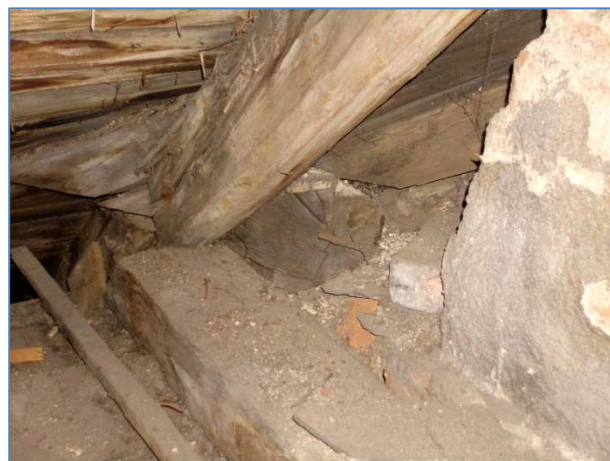
Obr.č.24: detail úžlabí v sondě S7
