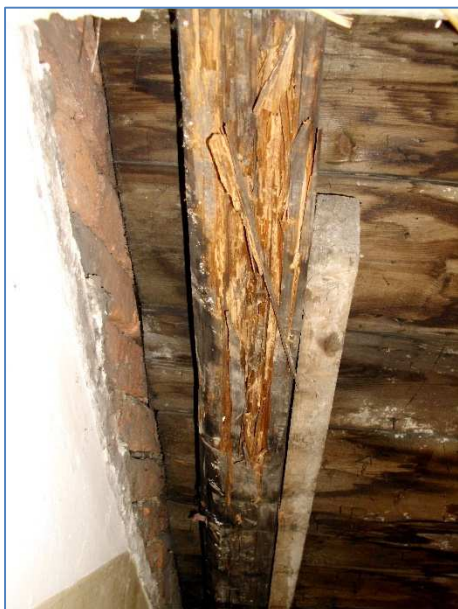
Obr.č.38 : poškození krokve v sondě S8
