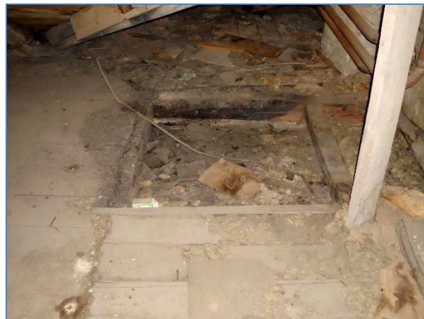
Obr.č.31 : ohořelé dř. prvky vodorovné kce pod úžlabím na poz.č.10
