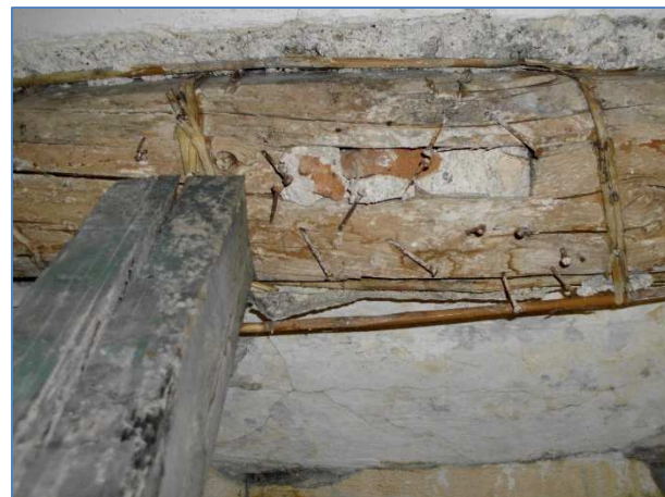
Obr.č.60 : detail poškození průvlaku povrchová hniloba – výsušné praskliny
