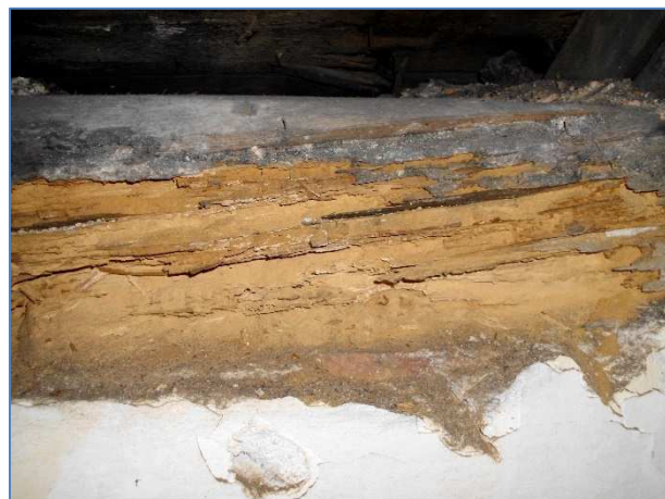
Obr.č.44 : detail kostičkového rozpadu pozednice
