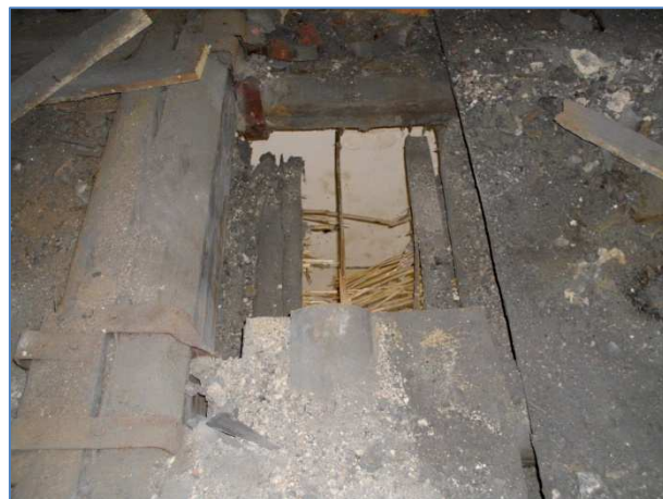
Obr.č.10: detail havarijního poškození vodorovné kce v sondě S3 Odběr vzorku VZ1
