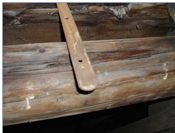
Obr.č.27 : destrukce vaznice pod revizním otvorem
