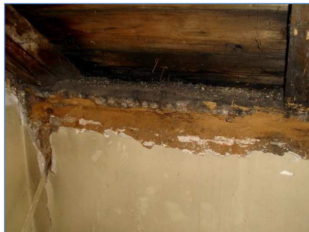
Obr.č.50 : totální destrukce pozednice Odběr vzorku VZ5
