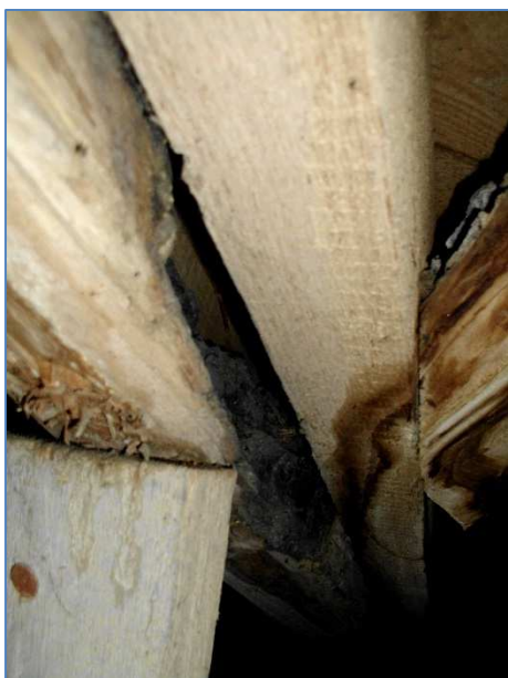
Obr.č.30 : totální destrukce zahořením úžlabní krokve na poz.č.10
