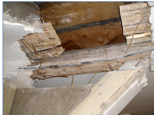
Obr.č.69 : pohled na obnažený průvlak nad sondou S12
