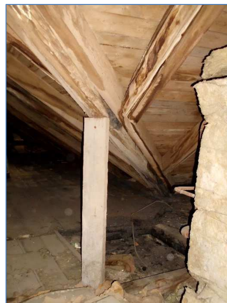
Obr.č.29 : zahořelé dřevěné prvky zesílené oboustrannou příložkou úžlabní krokv poz.č. 10
