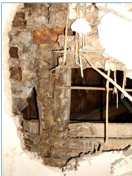
Obr.č.13: místnost 4.05 – 4.NP spodní pohled na destrukci vodorovné kce - sonda S3
