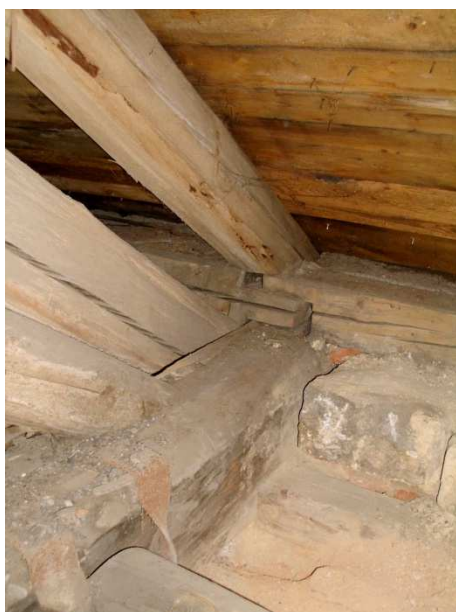
Obr.č.7: celkový pohled na patní část plné vazby – sonda S2
