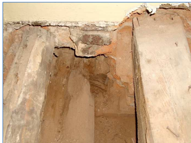
Obr.č.73 : totální destrukce rákosníkového trámu /RT/ ve zhlaví a uložení ( venkovní obvodová zeď )
