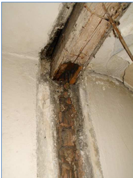
Obr.č.59 : detail chybějící části nosné kce (stojina)
