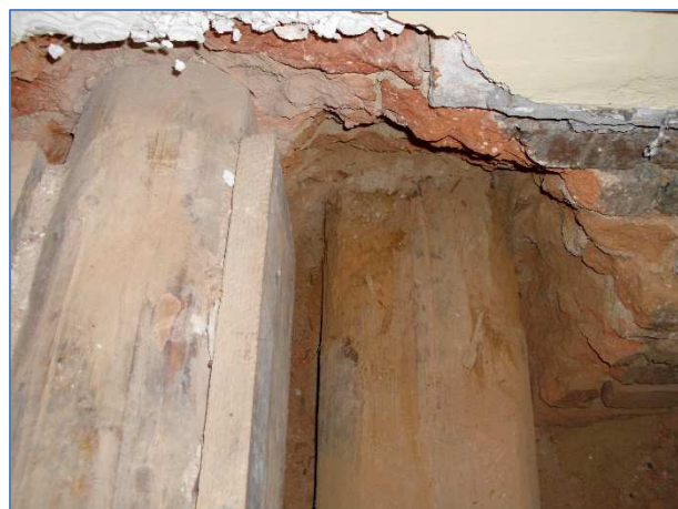
Obr.č.81 : destrukce rákosníkového trámu /RT/ ve zhlaví a uložení
