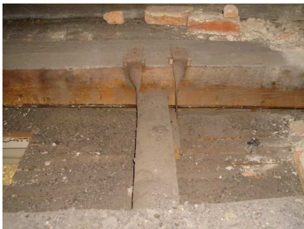
Obr.č.3: detail uchycení /kovový třmen/ ST a podbití - sonda S1
