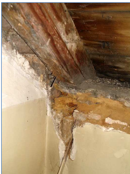
Obr.č.51 : destrukce konst. spoje krokv- pozednice
