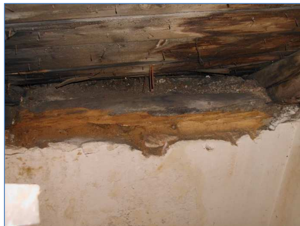
Obr.č.42 : totální destrukce pozednice Odběr vzorku VZ4
