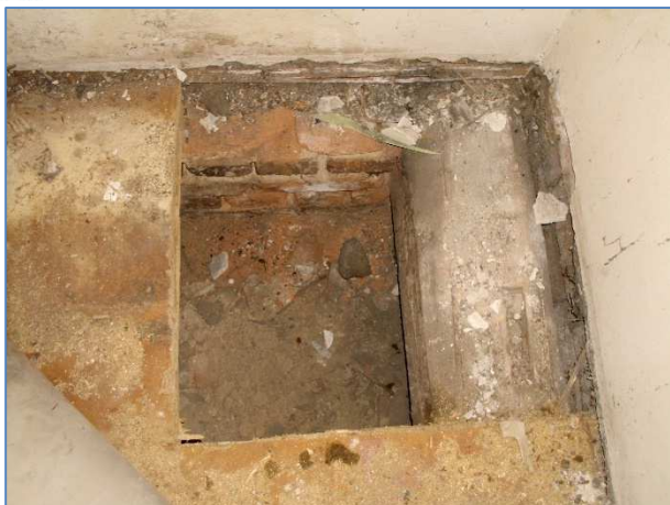
Obr.č.45 : pohled do sondy /pod S9 / vodorovná kce 4.NP
