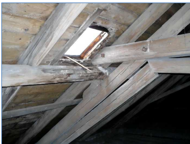
Obr.č.26 : celkový pohled na poškozenou horní stranu středové vaznice na poz.č.12
