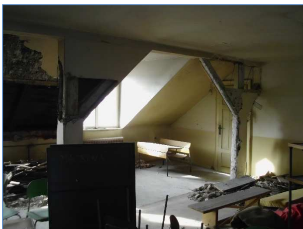
Obr.č.57 : celkový pohled na obnažené vodorovné a svislé kce sonda S10/4
