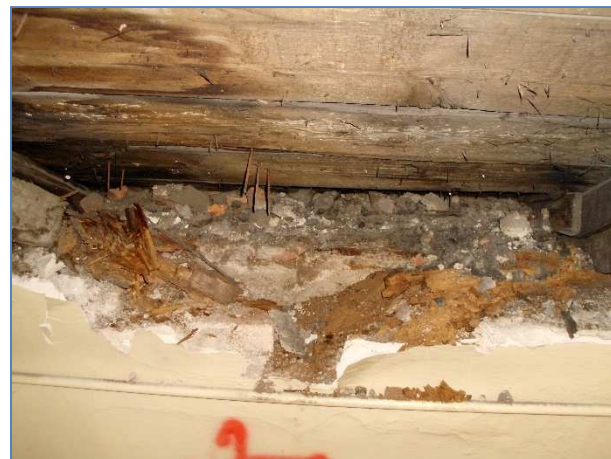
Obr.č.37 : totální destrukce pozednice Odběr vzorku VZ3
