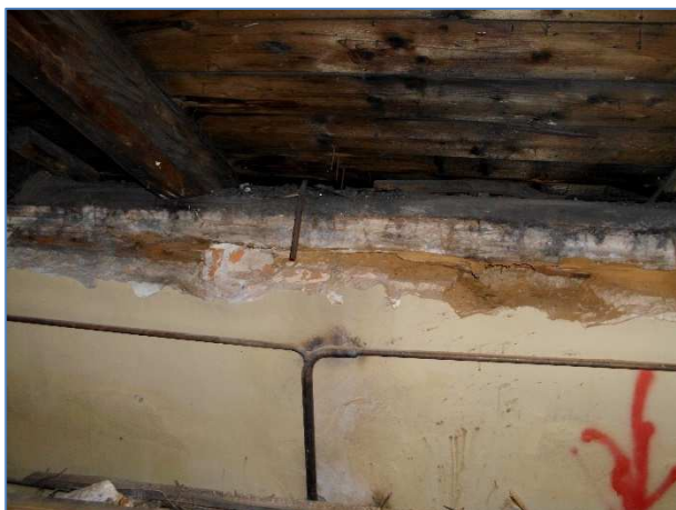
Obr.č.54 : totální destrukce pozednice
