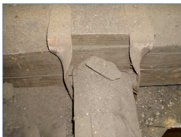
Obr.č.8: uchycení ST do třmenu v sondě S2
