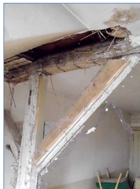
Obr.č.62 : detail prohnutí průvlaku
