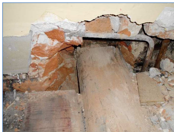
Obr.č.65 : detail uložení ST vodorovné kce - chodba 4.NP
