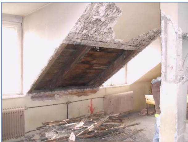
Obr.č.52 : celkový pohled na sondu S10/2
