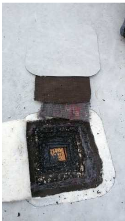
foto /21/ Pohled na jednotlivé vrstvy po bednění
