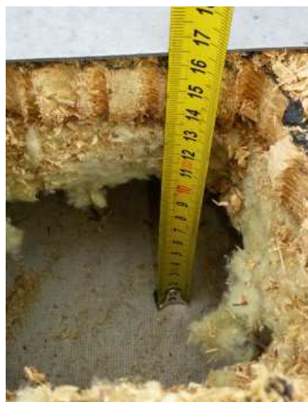
foto /15/ Tloušťky jednotlivých vrstev střechy B4
