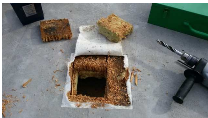
foto /5/ Jednotlivé vrstvy horního pláště střechy B2
