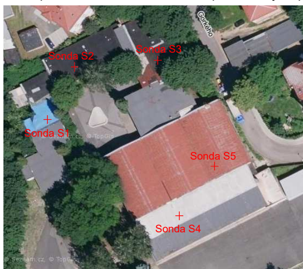
obr. /1/ Letecký snímek na střechy budov areálu LVT
