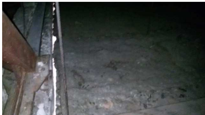
foto /40/ Pohled na tepelnou izolaci podhledu
