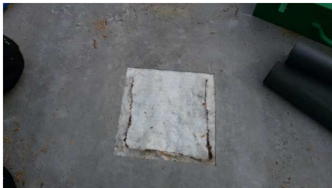
foto /3/ Odkrytí separační geotextilie pod PVC fólií
