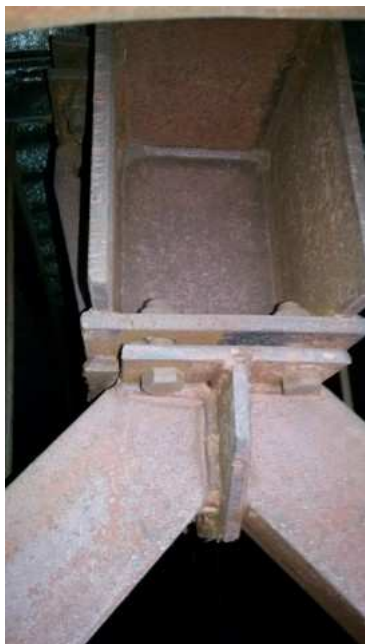
foto /41/ Pohled na nosnou konstrukci střechy D
