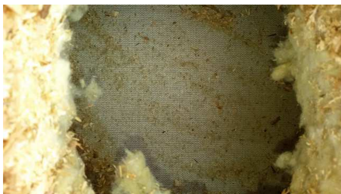
foto /14/ Jednotlivé vrstvy horního pláště střechy B2
