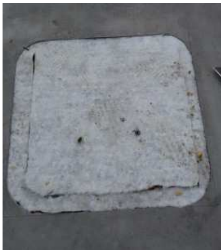
foto /12/ Odkrytí separační geotextilie pod PVC fólií
