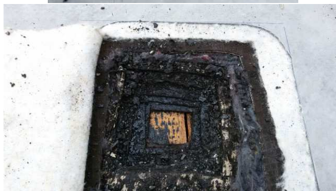
foto /22/ Pohled na původní PVC fólii foto /23/ Detailní pohled na souvrství asfaltových pásů
