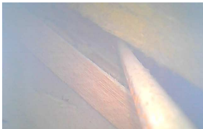
foto /27/ Pohled endoskopickou kamerou na dřevěné pomocné latě podhledu a ocelové táhlo
