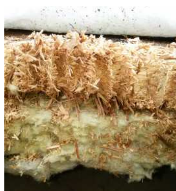
foto /6/ Pohled na prkenné bednění a tepelnou izolaci
