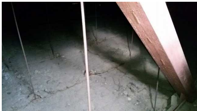
foto /39/ Pohled na tepelnou izolaci podhledu
