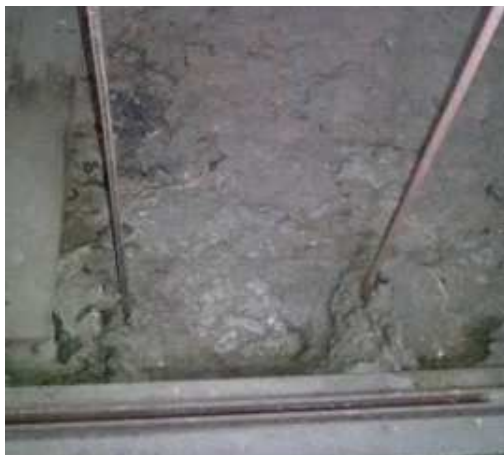
foto /37/ Pohled na tepelnou izolaci podhledu
