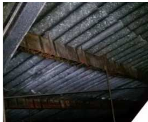
foto /36/ Pohled střešní krytinu ze strany interiéru + pohled na ocelovou vaznici
