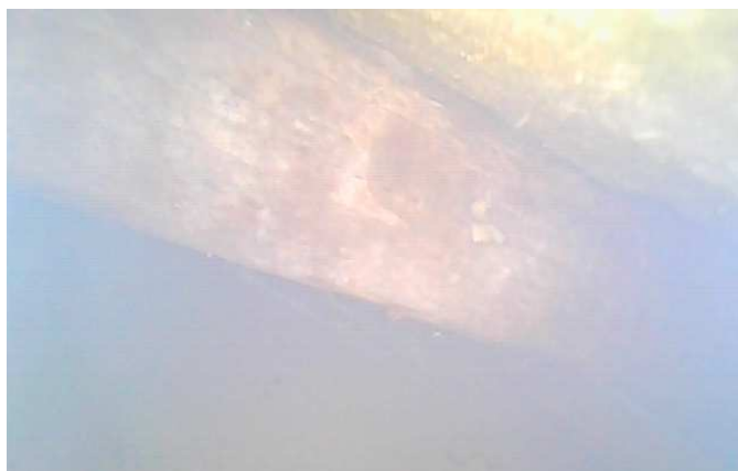
foto /26/ Pohled endoskopickou kamerou na vaznice
