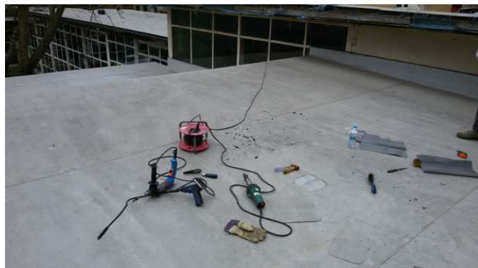
foto /20/ Pohled na provedenou sondu S3
