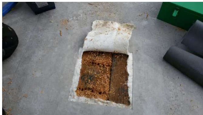
foto /4/ Odkrytí prkenného bednění
