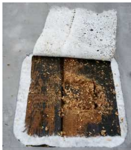
foto /13/ Odkrytí prkenného bednění
