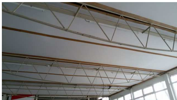
foto /10/ Pohled z interiéru na ocelové vazníky a pomocné dřevěné latě vynášející látkový podhled
