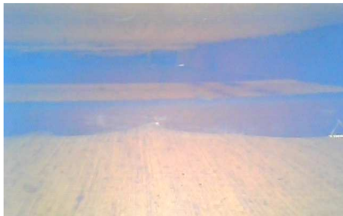
foto /19/ Pohled endoskopickou kamerou na dřevěné pomocné latě podhledu
