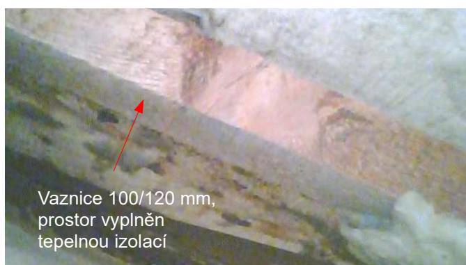
foto /8/ Pohled do vzduchové dutiny
