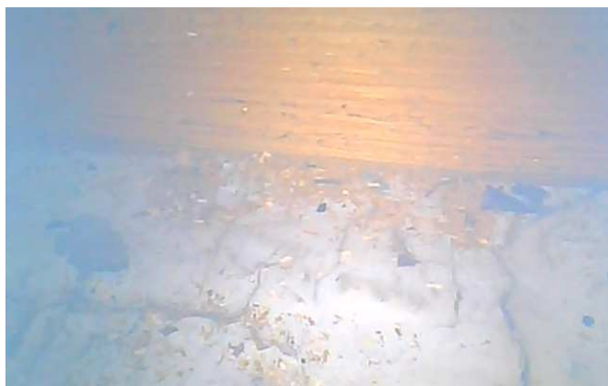
foto /34/ Pohled endoskopickou kamerou na vaznice
