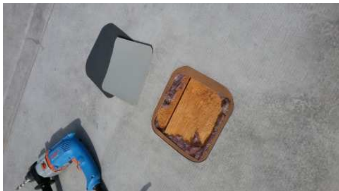
foto /30/ Pohled na prkenné bednění
