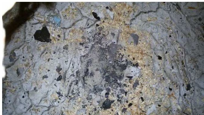
foto /33/ Drobná sonda do betonové desky pod vrstvou litého asfaltu a asfaltového pásu
