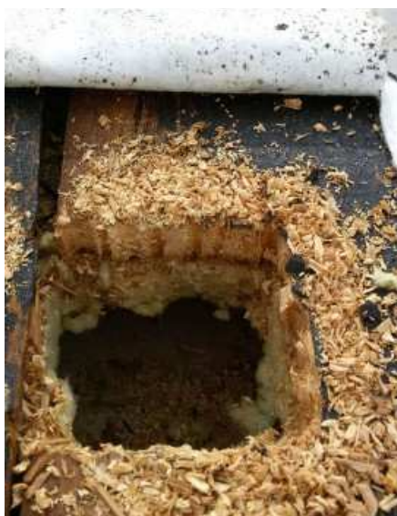
foto /14/ Jednotlivé vrstvy horního pláště střechy B2
