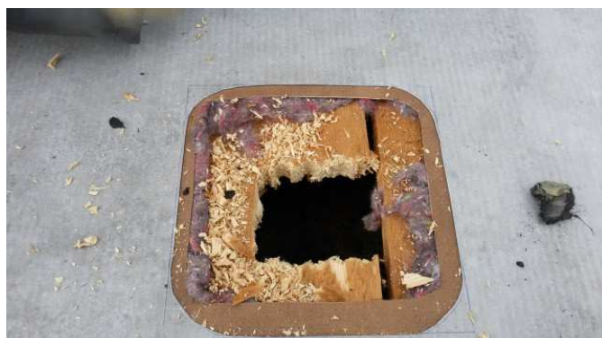
foto /31/ Sonda skrz prkenné bednění
