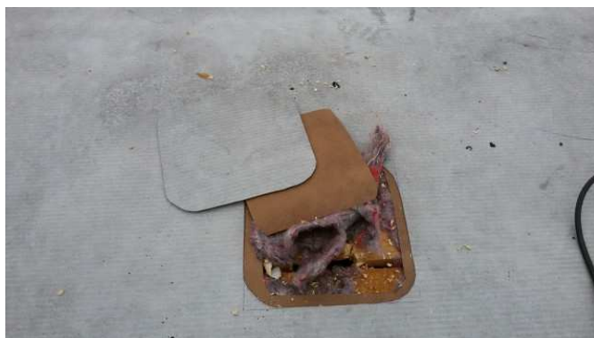
foto /28/ Pohled na jednotlivé vrstvy po bednění
