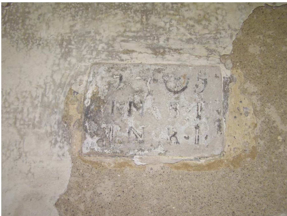
20. Nápisová deska nad vstupem do hrobové komory
