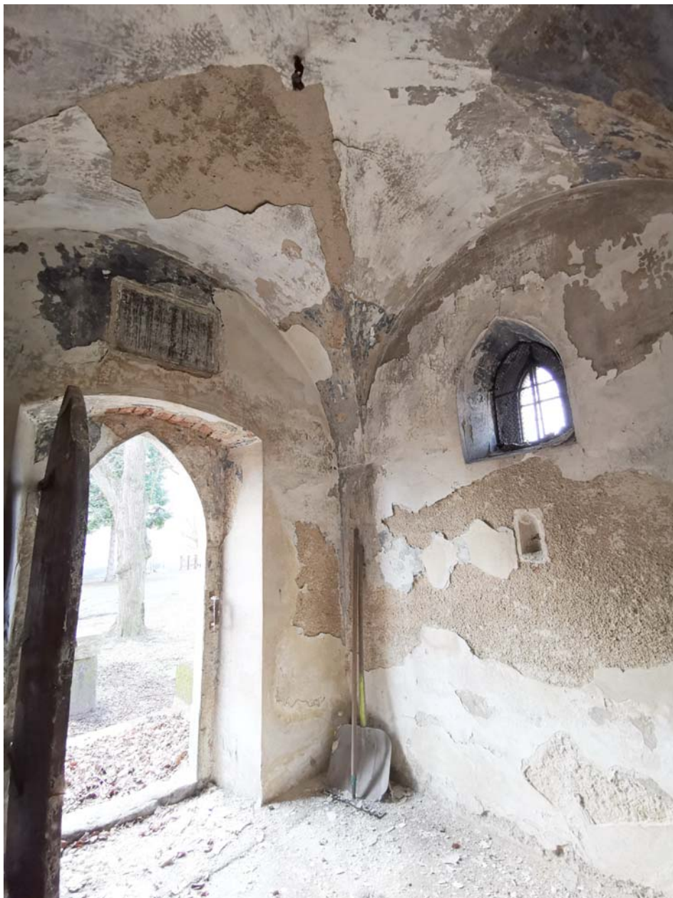
13. Interiér kaple - přední místnost
