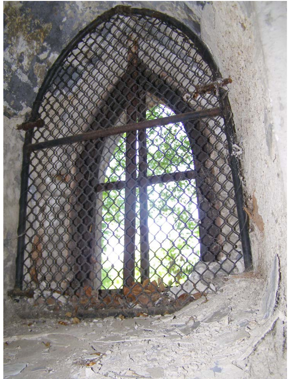
16. Okno na západním průčelí se zachovaným rámem
