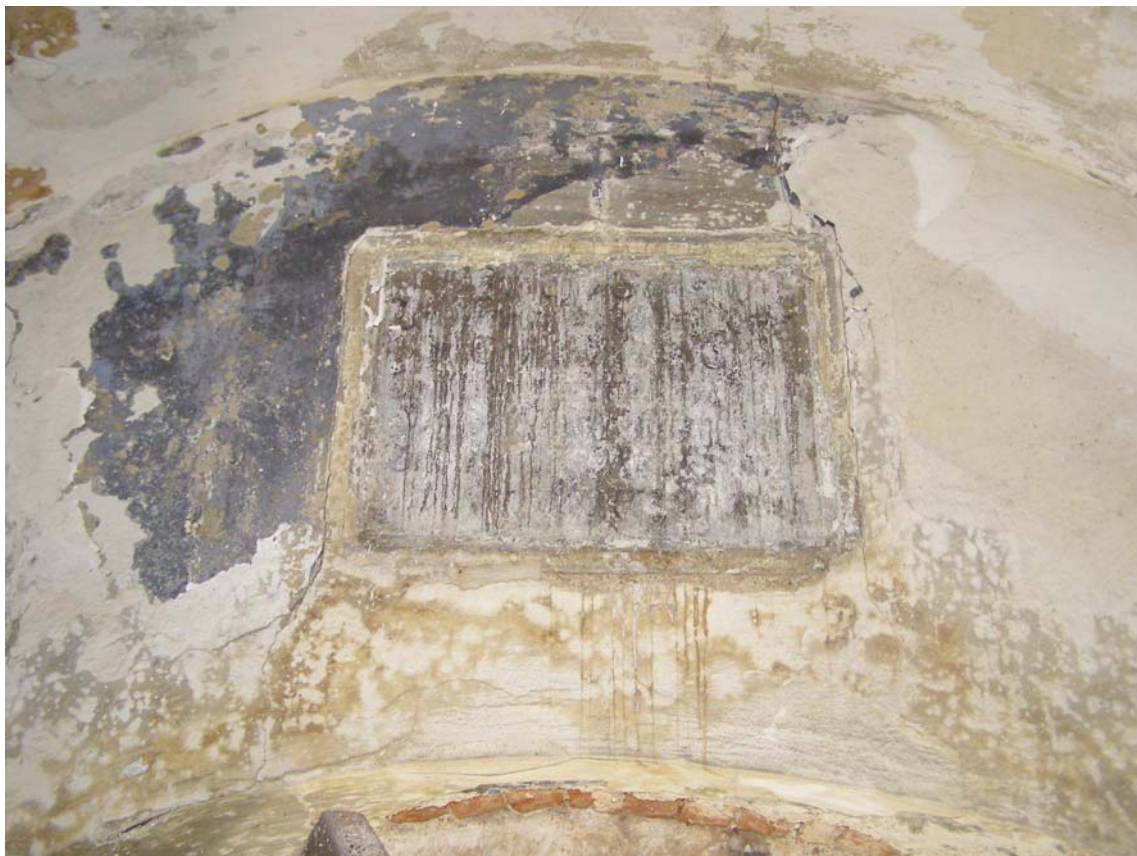
19. Nápisová deska nad vstupem do kaple
