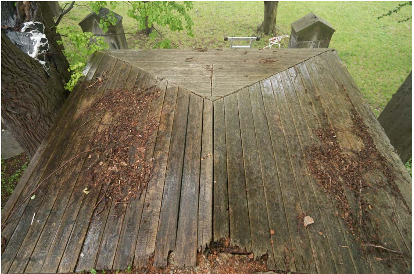
9. Bednění střechy (bez krytiny)
