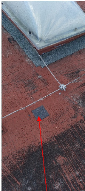
Následné zapravení sondy
