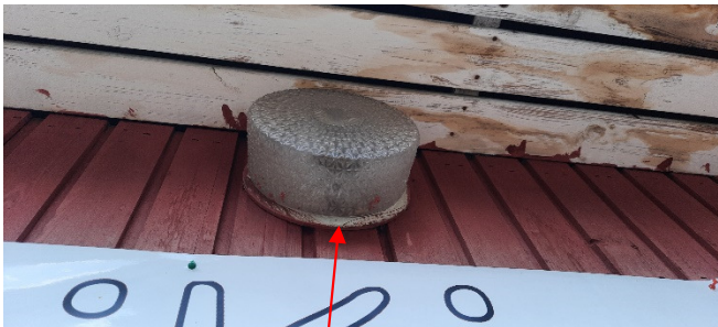
Azbestové izolační podložky
