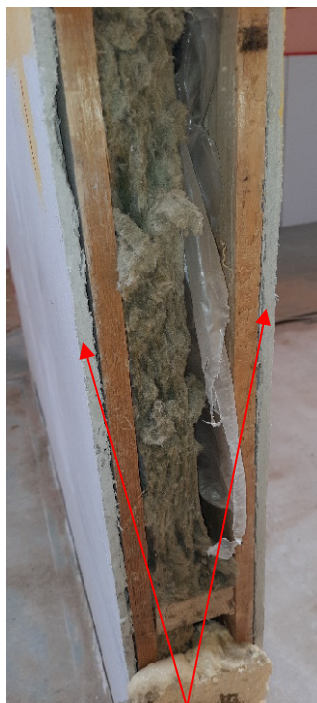
Skladba vnějšího pláště (azbestové desky)
