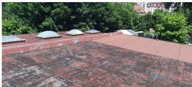
Místo odběru vzorku asfaltové lepenky
