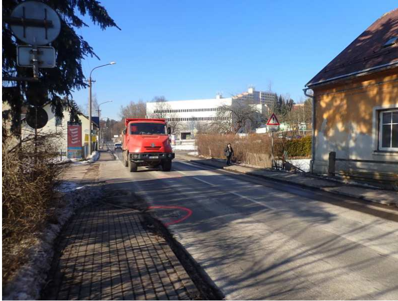
Označené poruchy na vozovce
