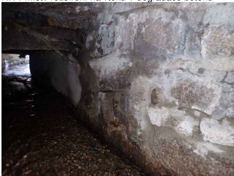
Opěra na vtoku vpravo–zdivo po opravě, lehce vyboulené a s lok. trhlinami ve spárování
