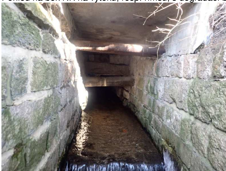
Pohled na výtok, včetně výtokové kamenné čelo a chráničky pod rozšířením propustku
