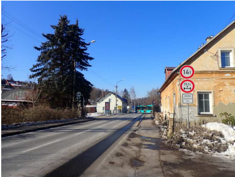
Celkový pohled na propustek z levobřežního předpolí
