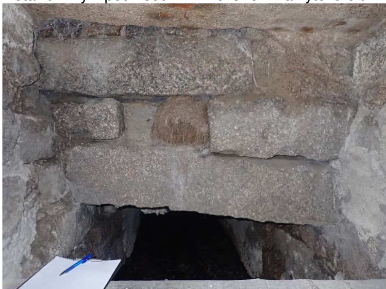
Pohled na výtokovou čelní zeď na rozhraní původní a rozšířené části propustku
