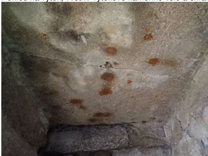
Podhled NK na výtoku s podélnou trhlinou
