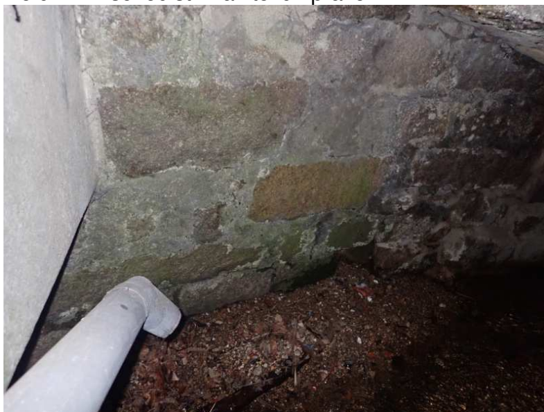
Pohled na vtok – prostor mezi domem (+ svod) a propustkem
