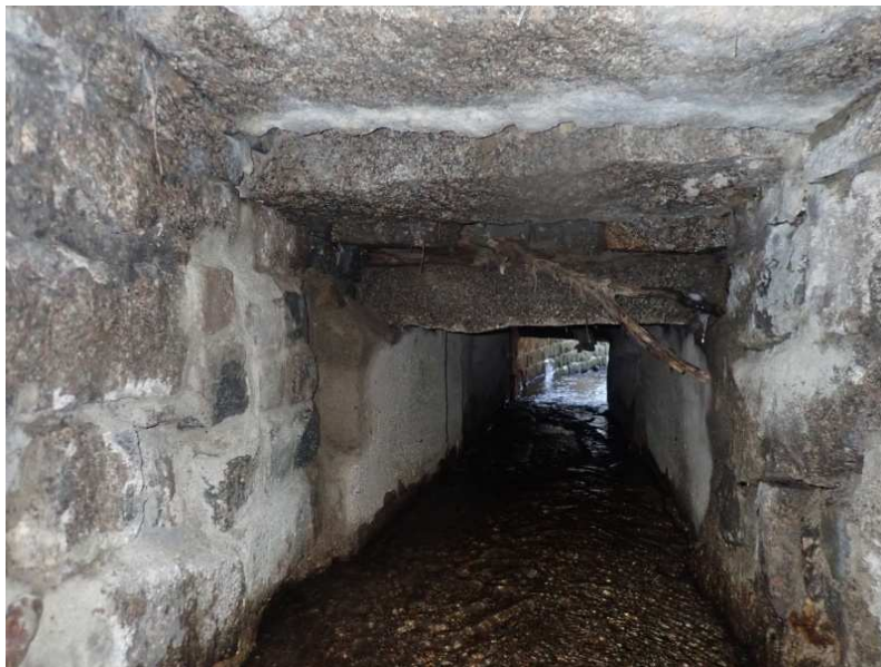
Podhled NK na vtoku
