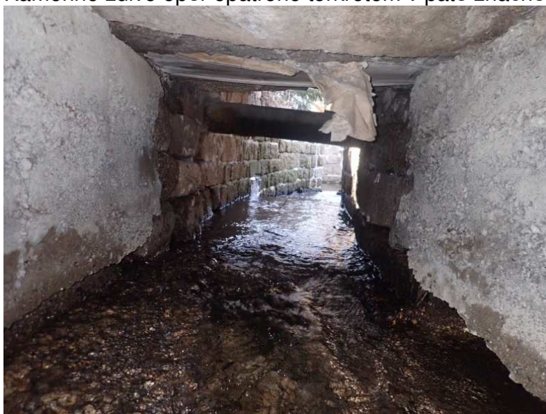
Kamenné zdivo opěr opatřené torkretem v patě značně podemleté
