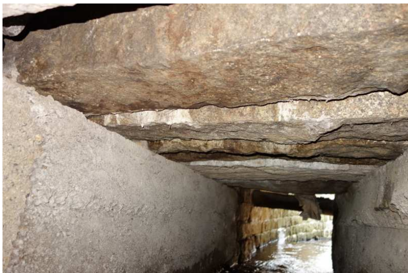
Podhled NK (kamenné překlady) ve směru toku pod MK
