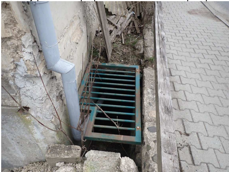
Pohled na vtok
