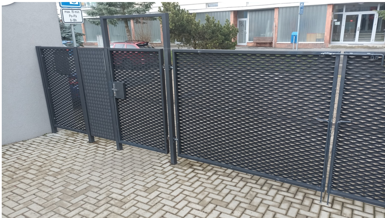
Obrázek 1 – stávající vzhled oplocení u hlavního vstupu do areálu MŠ Beruška tvořený kovovým plotem s brankou a dvoukřídlovou bránou s výplní tahokovem lakovaným do černého odstínu
