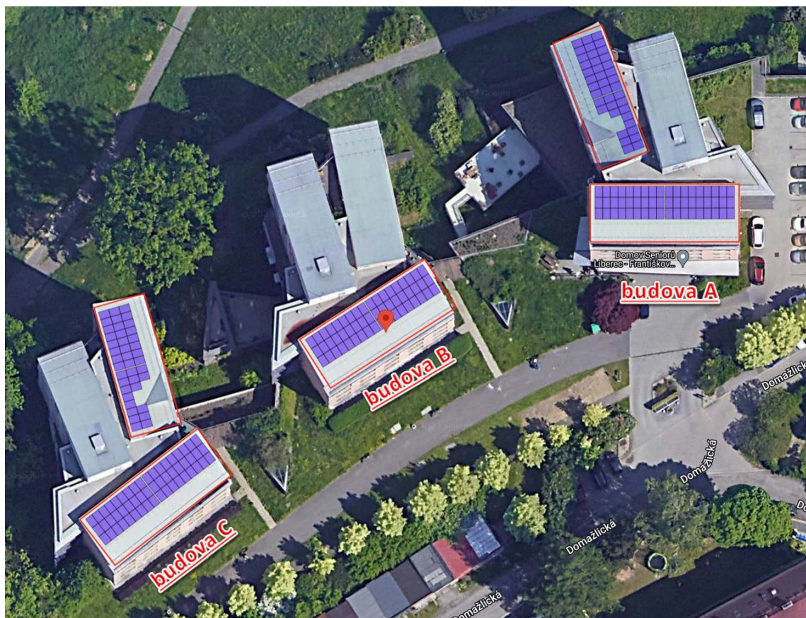
Obrázek 1: Celkový orthofoto pohled na navrhovanou FVE na střechách DS Františkov
