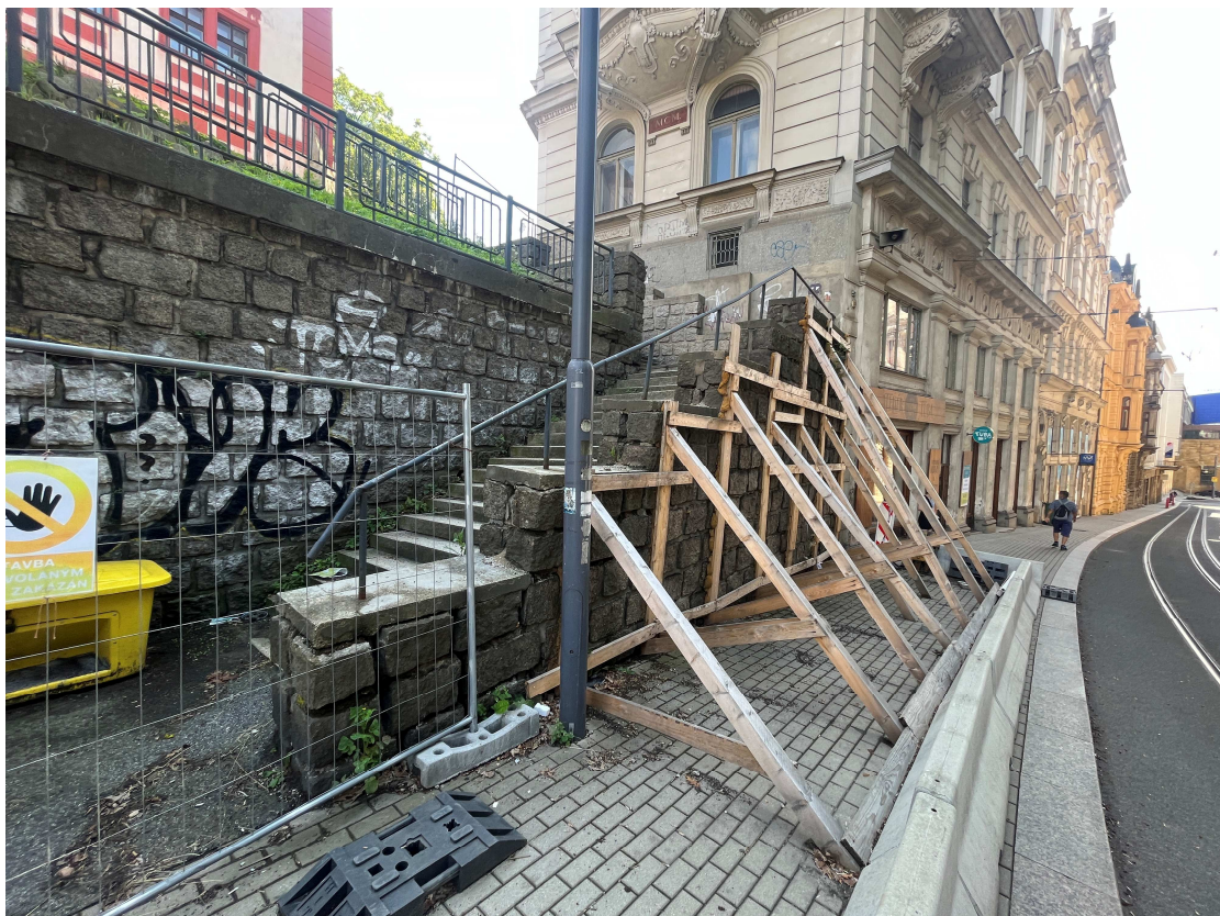
Obrázek 1 - Podepření zdi u schodiště v ulici Rumunská
